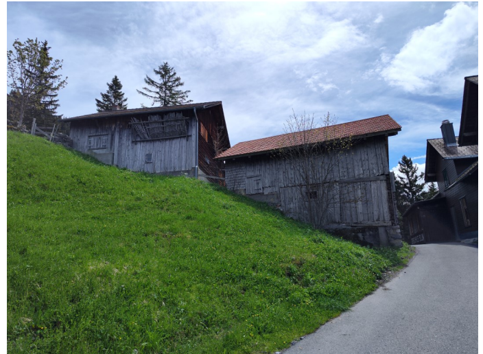
Abb. 2: Triesenberg, Silumstrasse 49: Bergseitig letztes Gebäude einer kleinen Baugruppe aus zwei baugleichen Alphütten, die auf einem Grat in Falllinie aufgereiht sind.
