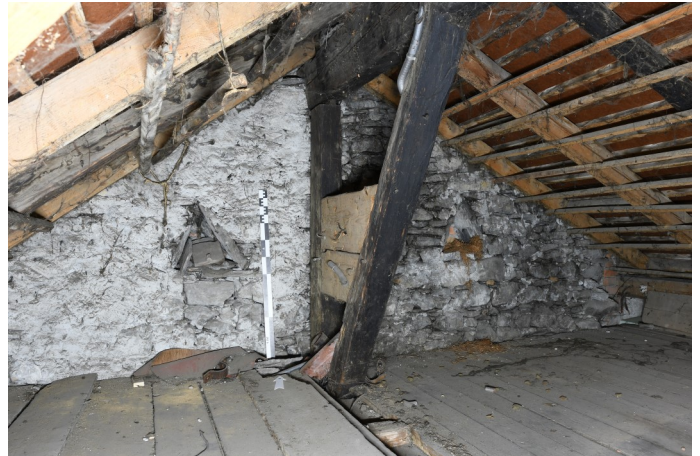
Abb. 1: Balzers Pralawisch 22 (R401). Firstständerwand (datiert 1624) und Anschluss an die nördliche Giebelwand.
