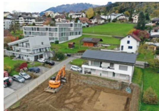
Abb. 9 Mauren, Veterangasse. Baugrube mit händisch gereinigten Teilflächen. Blick gegen Westen.
