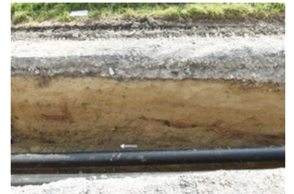
Abb. 1 Balzers, Rietstrasse/Züghüsle. Das mögliche Fundament liegt direkt über dem grauen Schwemmsilt. Darüber eine Planie aus braunem Schotter (Strassenkoffer?) und der moderne Strassenaufbau.
