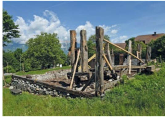
Abb. 11 Schaan, Raimundstorkel. Das schon weitgehend rückgebaute Gebäude mit den noch vorhandenen massiven Balken des Torkels (Presse) im Inneren. Senkrecht die Vorderdocken. Blick gegen Nordwesten.
