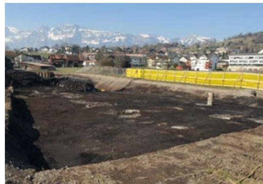
Abb. 2 Eschen, Essanestrasse. Gesamtaufnahme des Bauperimeters mit Blick nach Nordwesten.
