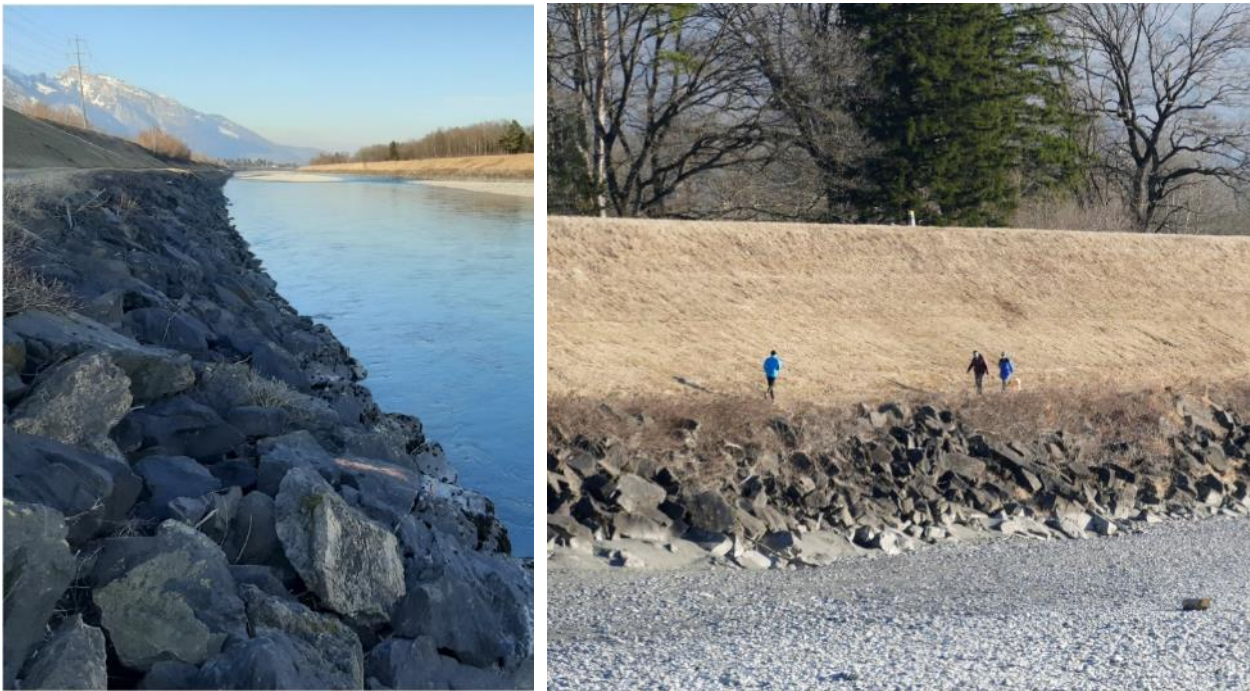
Abbildung 8: Blocksteinverbauung unterhalb des wasserseitigen Wuhrweges.
