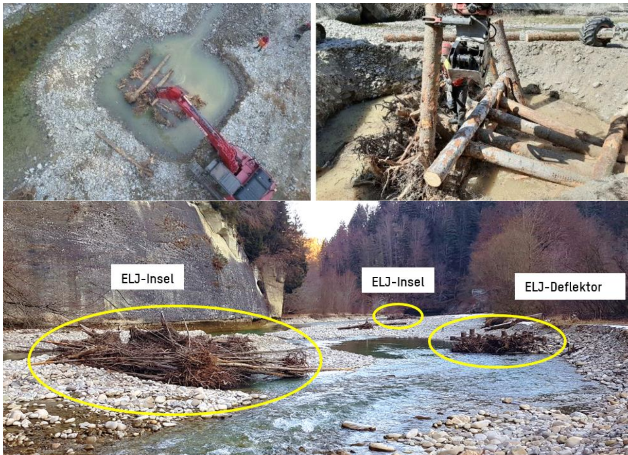
Abbildung 26: Engineered Log Jams zur ökologischen und morphologischen Aufwertung in einer Aue von nationaler Bedeutung (Sense, Ruchmühle, Projekt Emch+Berger AG.)
