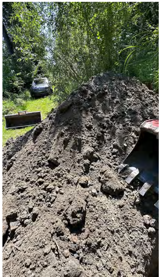
kiesiger Sand mit Steinen und kleinen Blöcken
