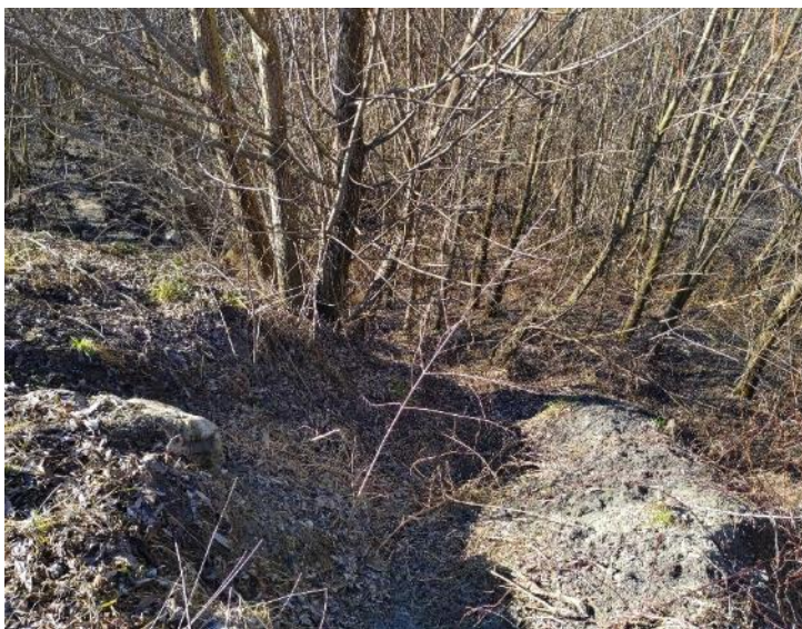
Foto 2: Böschung des bestehenden Deponiekörpers (FL) mit Erosionsstellen
