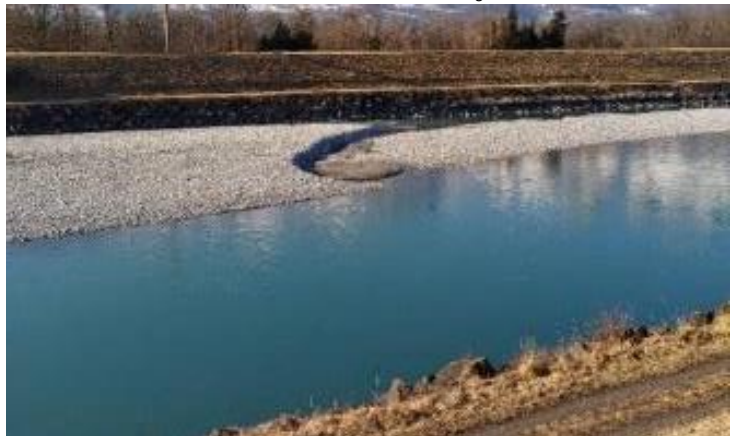
Foto 35: Blick auf Rheindamm SG, Kiesbänke (Auflandungstendenz: neue, höhere Bank schiebt sich über ältere, tiefere).
