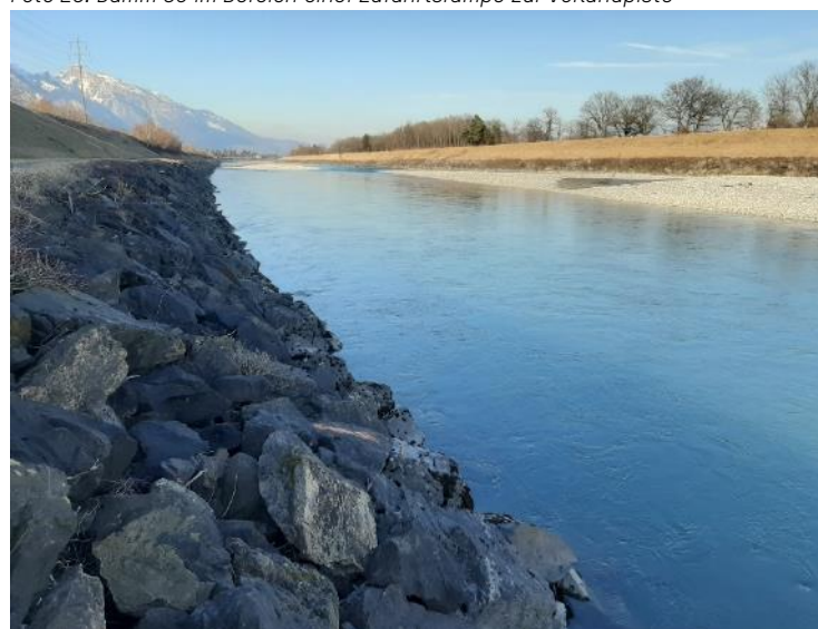
Foto 29: Uferschutz mit Blocksteinen unterhalb der Vorlandpiste, SG
