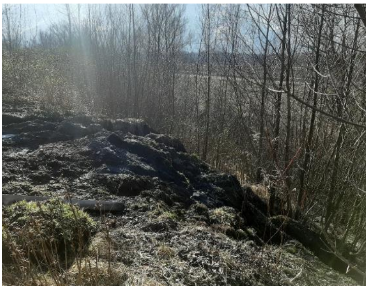
Foto 1: Bestehender Deponiekörper (FL), welcher als rückversetzter HWS-Damm geschüttet wurde (Im Hintergrund der Rheindamm)
