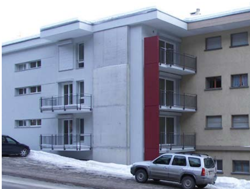
Ansicht an die Nordfassade mit einer neuen aussenliegenden Stahlbetontragwand.
