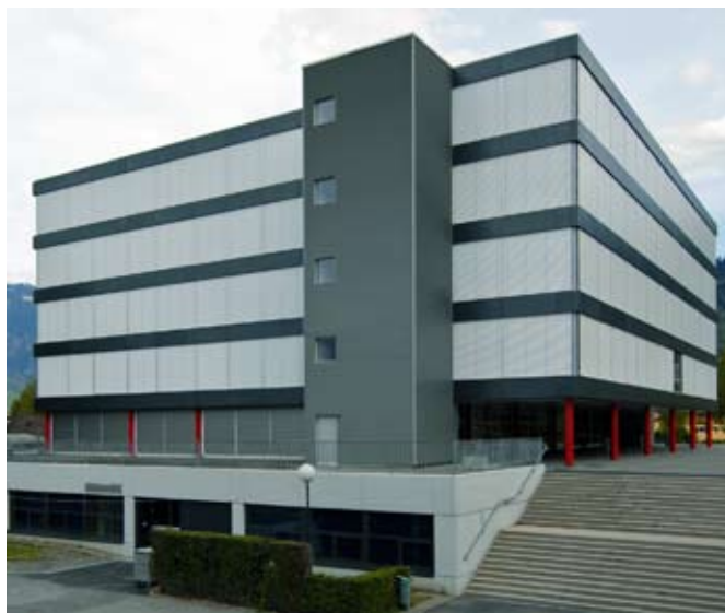
Ansicht an den neuen Treppenturm auf der Nordseite.
