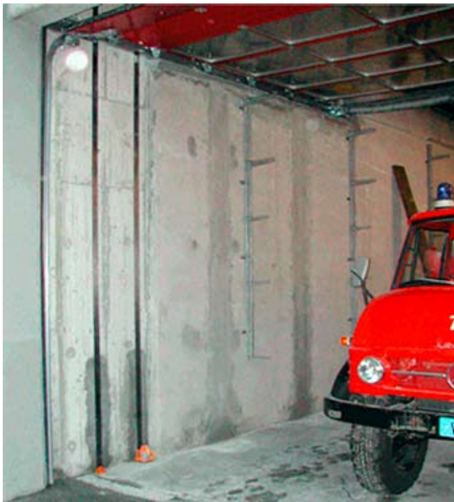
Zwei vorgespannte CFK-Lamellen auf der Innenseite der Giebelwand (Truffer et al. 2004).
