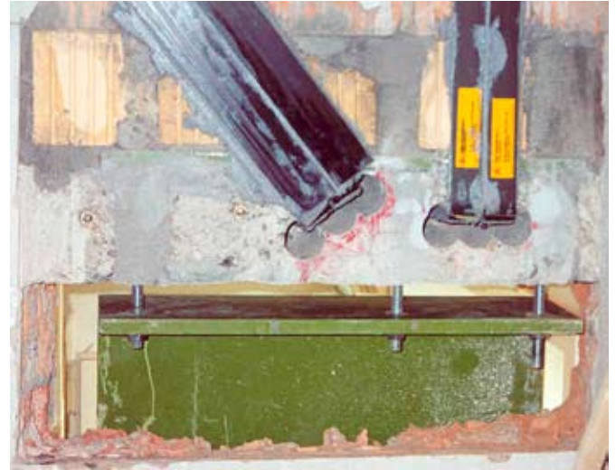
Verankerung der Kohlefaserlamellen mit Schubwinkeln in der Betondecke.
