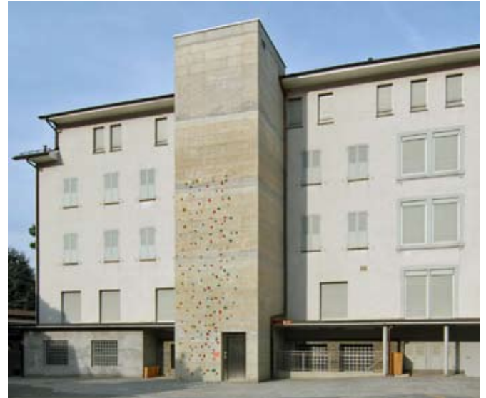
Ansicht an die hintere Längsfassade mit dem neuen Stahlbetonliftkern
