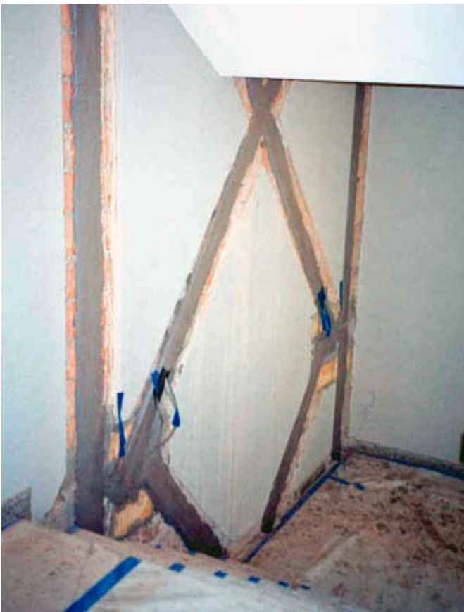
Verstärkung der Mauerwerkswände im Treppenhaus mit Kohlefaserlamellen.
