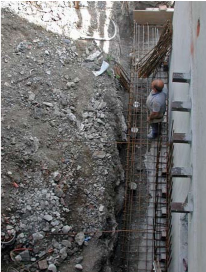
Foundation einer der neuen Stahlbetonwände.
