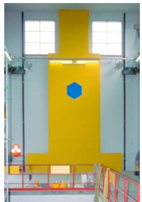
Neue Stahlbetontragwand auf der Innenseite der Ostfassade der Montagehalle.
