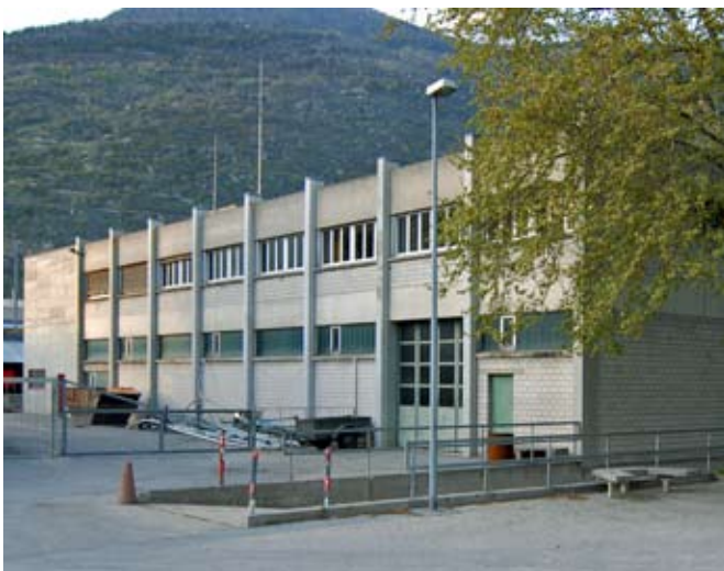
Rückseitige Längsfassade des Feuerwehrgebäudes mit der aussteifenden Stahlbetontragwand am linken Rand.
