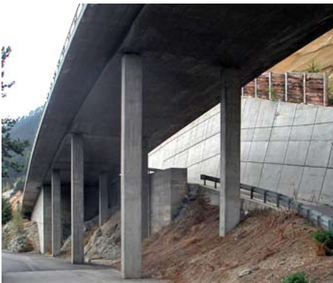
Blick auf einen Brückenabschnitt mit hohen schlanken Stützen.
