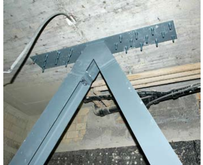
Verankerung des neuen V-förmigen Stahlfachwerks in der Bodendecke des ersten Obergeschosses.
