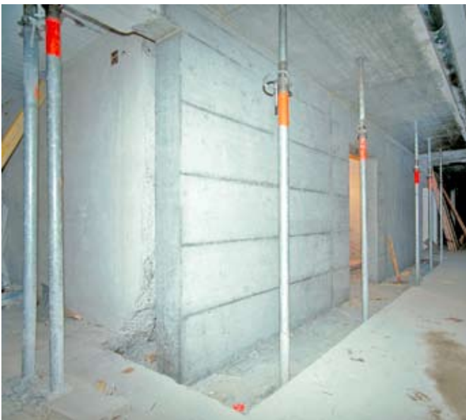
Neue gekoppelte Stahlbetontragwände im Untergeschoss.
