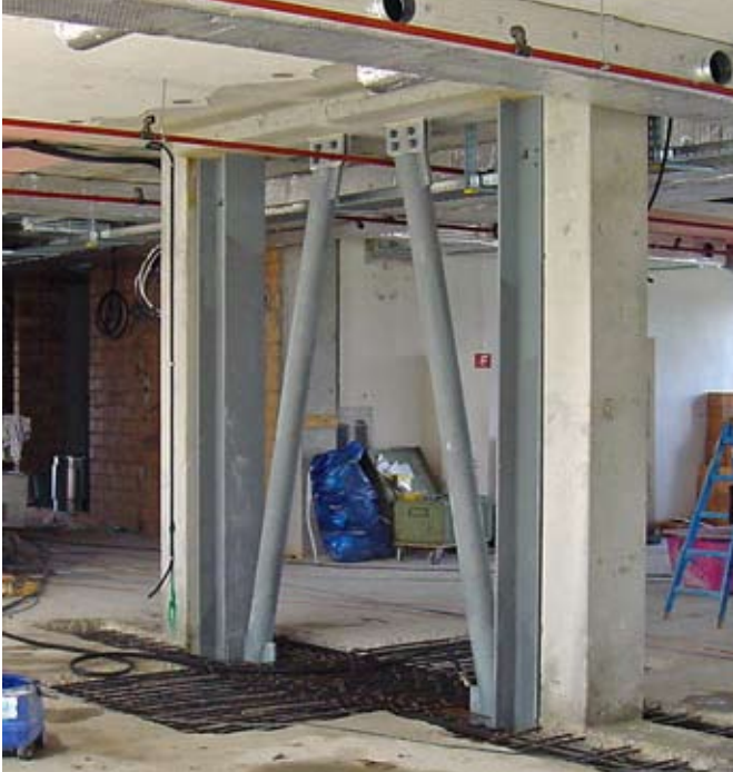
Neues exzentrisches Stahlfachwerk eingebaut zwischen zwei bestehenden Stahlbetonstützen.
