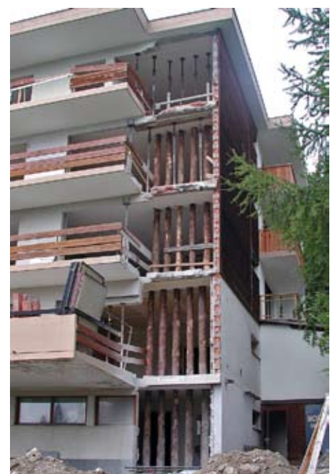
Umbau der Süd-Ost-Ecke.
