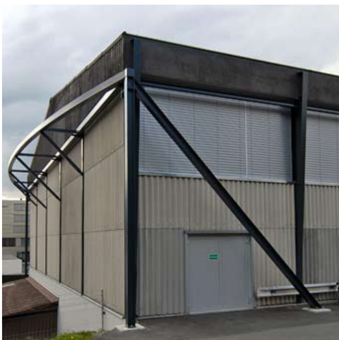
Fischbauförmige Verstärkung der stirnseitigen Fassadenstützen.
