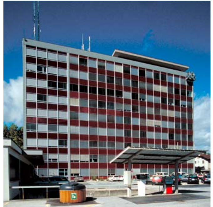
Ansicht an die Längsfassade. Die ersten vier Fensterreihen von links gehören zum Anbau.
