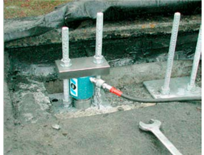
Die Vorspannung der CFK-Lamellen erfolgte vom Dach aus (Truffer et al. 2004).
