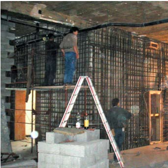
Einbau der Bewehrung der neuen Stahlbetonwände im Erdgeschoss.
