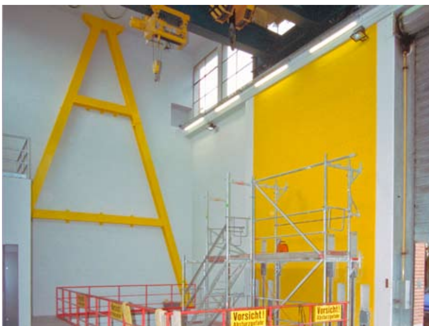
Neues Fachwerk in der Westfassade und neue Stahlbetontragwand in der Nordfassade der Montagehalle.
