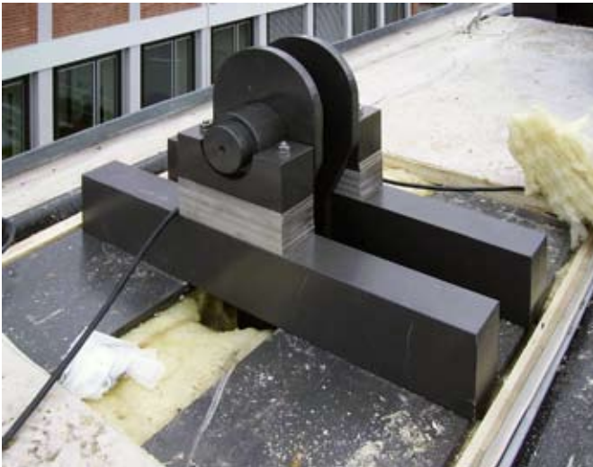
Obere Verankerung der CFK-Spannglieder auf dem Dach, von wo aus vorgespannt wurde.
