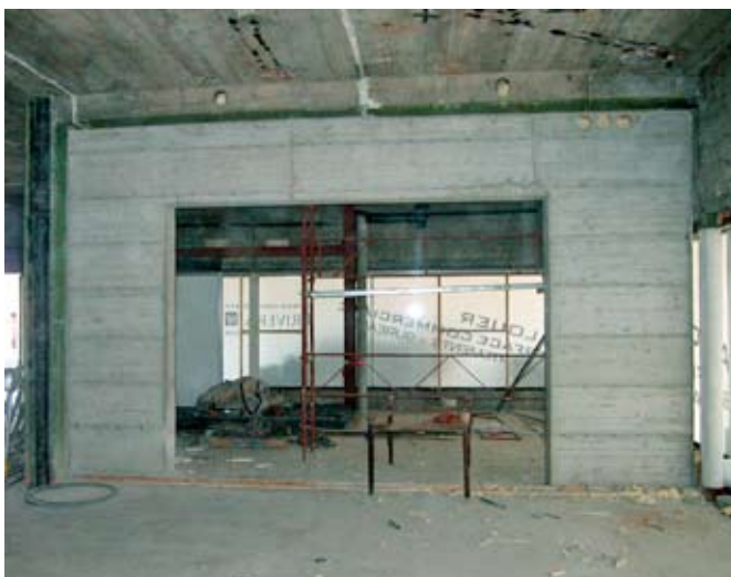
Neuer Stahlbetonrahmen im Erdgeschoss.
