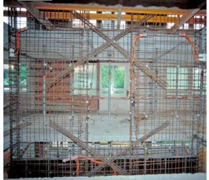
Bewehrung der neuen gekoppelten Stahlbetontragwände im Erdgeschoss mit diagonalen Stabbindeln in den Koppelungsriegeln.
