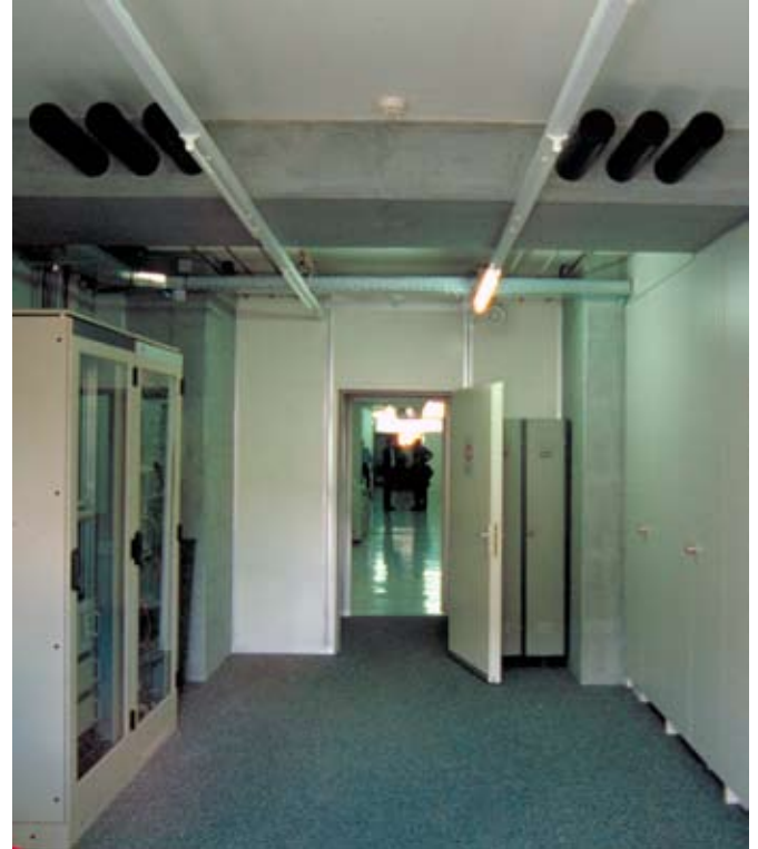
Ansicht an die 6 Verankerungen der Spannglieder am Querträger zwischen den beiden neuen I-förmigen Stahlbetonwänden im Anbau.
