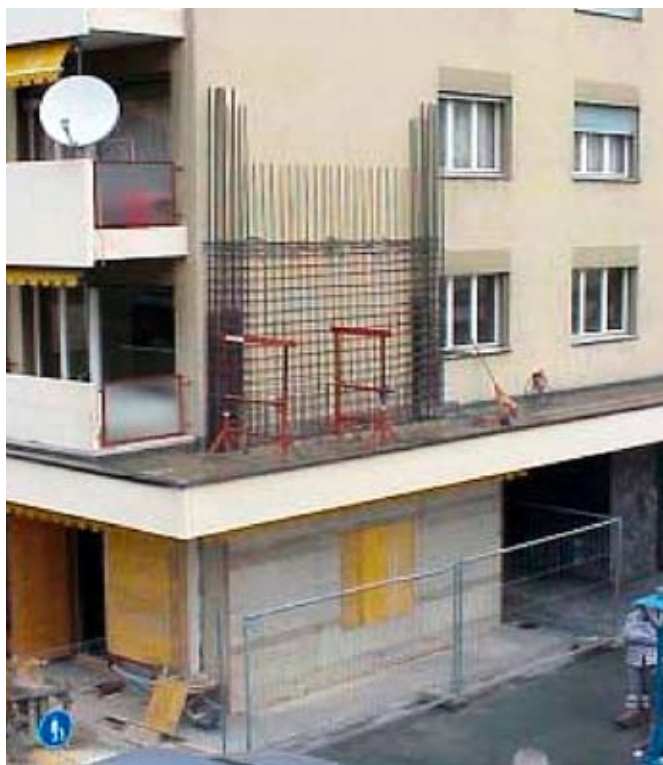
Neue aussenliegende Stahlbetontragwand wird an die bestehende Fassade betoniert (Lateltin 2003).
