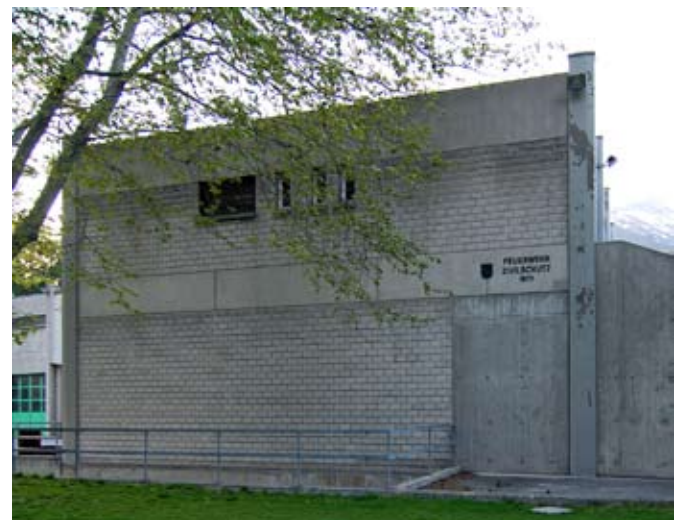
Nachträglich mit vertikalen CFK-Lamellen verstärkte Giebelwand aus Mauerwerk.
