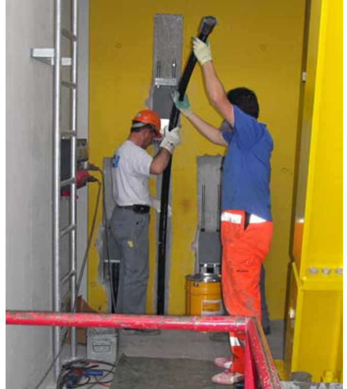
Einfädeln der CFK-Lamellen zur Verankerung der neuen Stahlbetontragwand.
