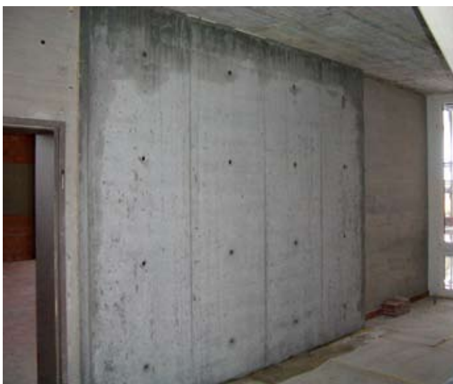
Verstärkung einer bestehenden Stahlbetonwand mit einer 15 cm dicken Aufdoppelung.
