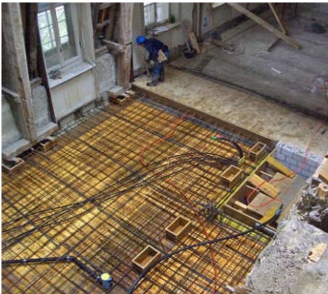
Betondecke im Bereich eines neuen Erschliessungskerns.
