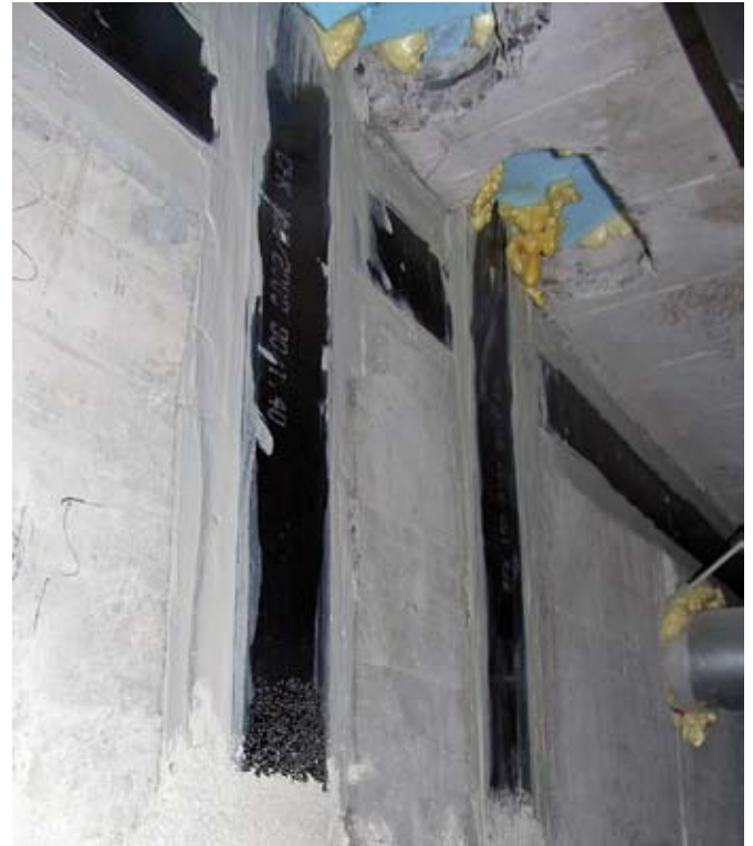
Verstärkung der Liftkerne mit aufgeklebten Kohlefaserlamellen.
