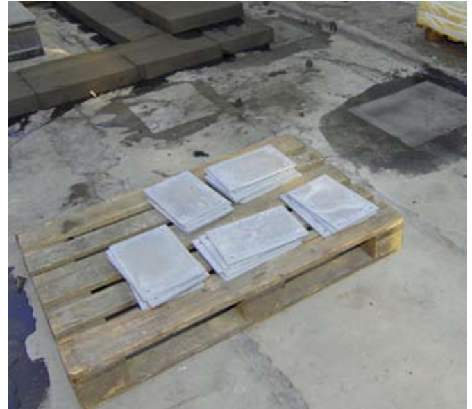
Stahlplatten zur Verbindung der Dachelemente.
