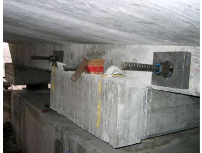
Zusammenspannen der beiden Brückenhälften bei der ursprünglichen Dilatationsfuge in Brückenmitte.
