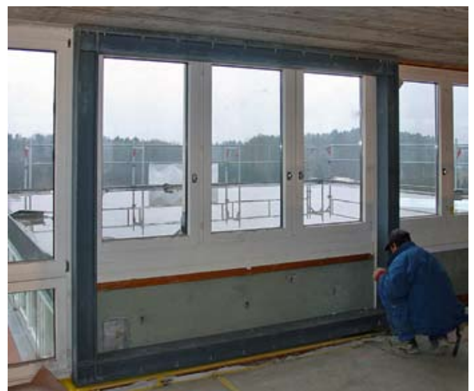
Aussteifung des Dachgeschosses mit neuem Stahlrahmen.
