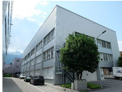
Süd- und Ostfassade
