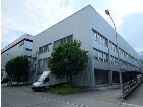
Ost- und Nordfassade
