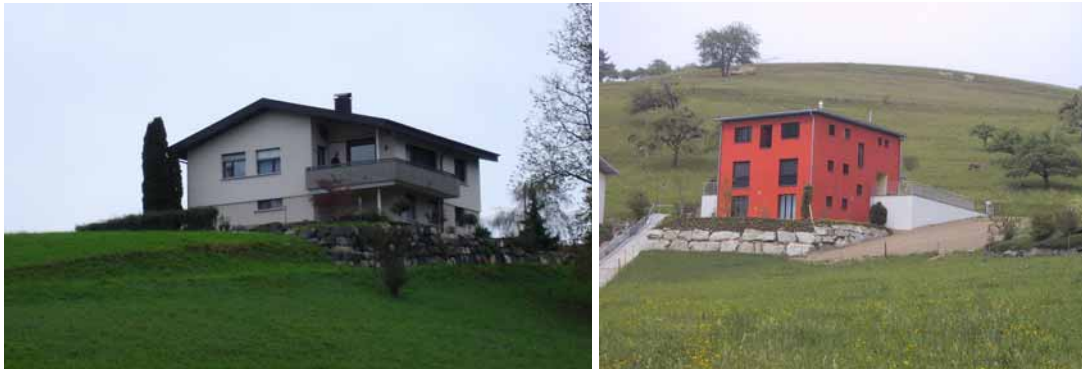
Gebäude auf unnötigen 'Maulwurfshügel' im sanft geschwungenen, sensiblen Relief
