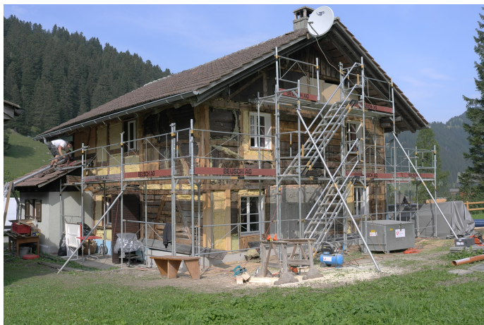
Abb. 1: Ansicht 2012 während Umbau und wärmetechnischer Sanierung.
