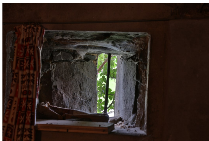
Abb. 4: Kellerluzide spätmittelalterlicher Art, hier von 1678.
