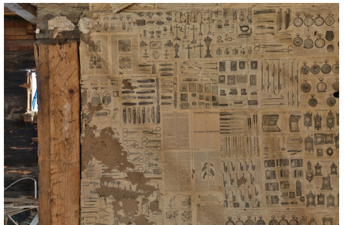
Abb. 6: In den Kammern sind die Oberflächen der Blockbauwände mit Drucksachen der Jahrgänge 1885 bis 1900 beklebt.
