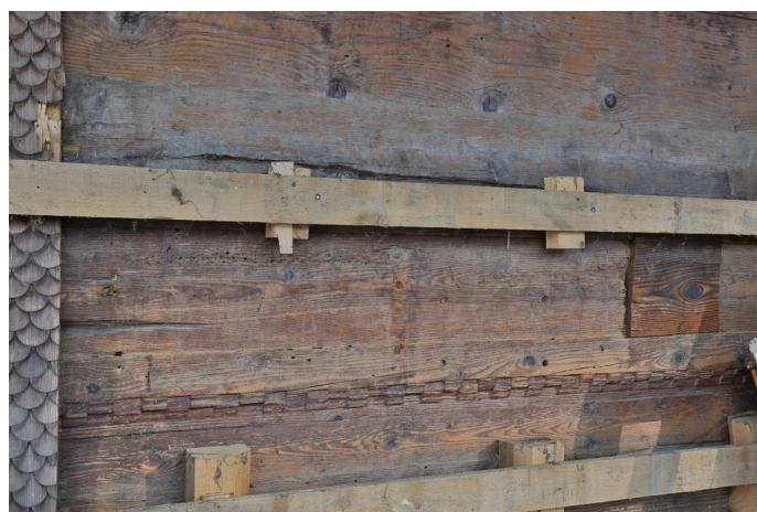
Abb. 3: Zahnschnittfries als Fassadendekor von 1678.
