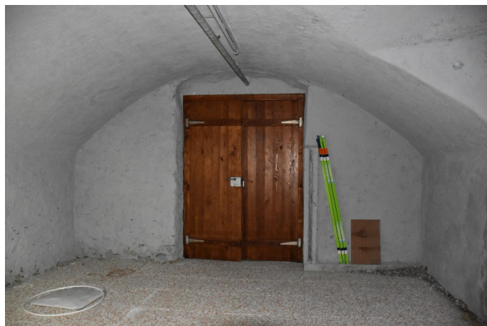
Abb. 2: Eschen, Hinterdorf 9, Keller mit Eingang.
