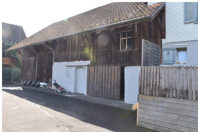
Abb. 4: Eschen, Hinterdorf 9, Nordfassade Ökonomieteil.
