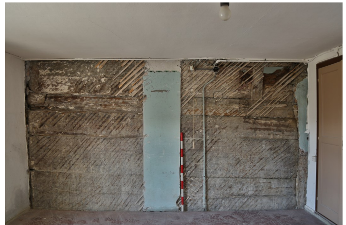
Abb. 6: Blockbauwand im Obergeschoss, Südansicht mit Ständer rechts und Wanderhöhung von 1864.
