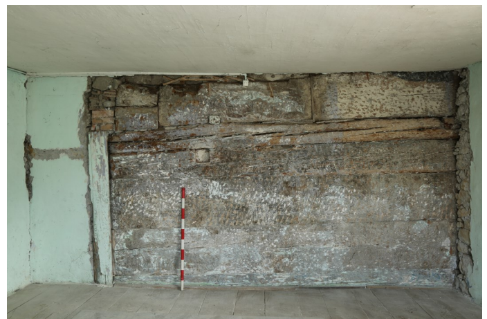
Abb. 7: Blockbauwand im Obergeschoss, Nordansicht mit Ständer links und Wanderhöhung von 1864.
