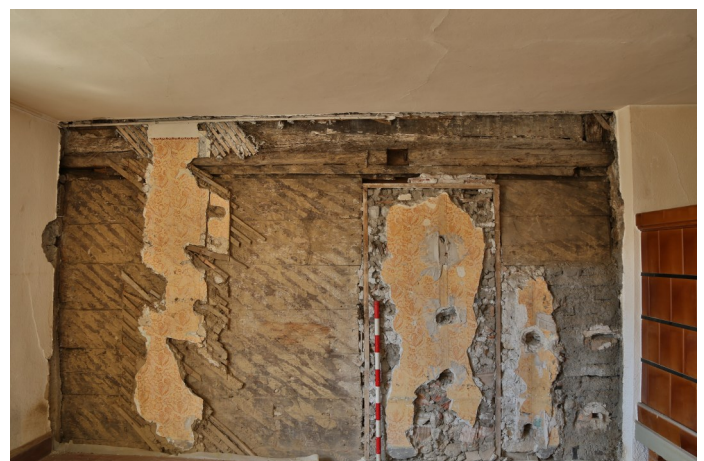
Abb. 4: Blockbauwand im Erdgeschoss, Südansicht mit Deckennut, Türöffnung und Ofenstandort.
