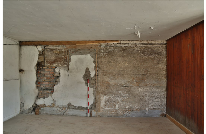
Abb. 5: Blockbauwand im Erdgeschoss, Nordansicht mit Deckennut, Türöffnung und Ofenstandort.
