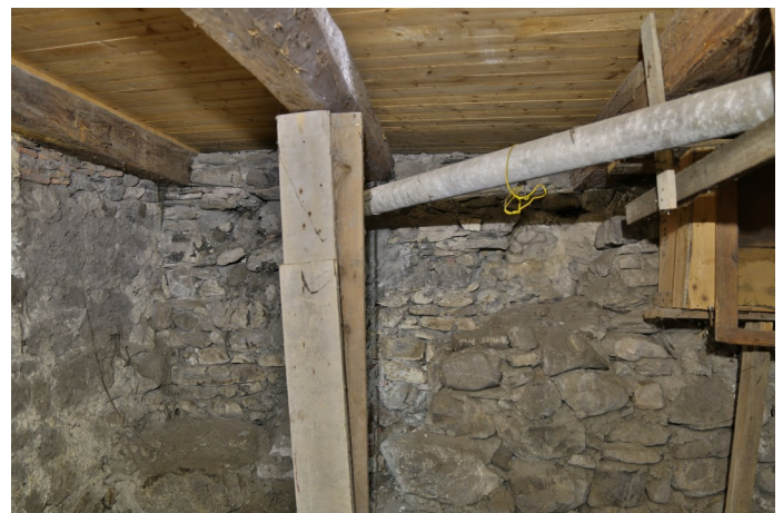
Abb. 3: Keller im Hausteil C, Nordwestecke mit Mauerwerk des Kernbaus 1401 und einer Vormauerung von 1876-80.
