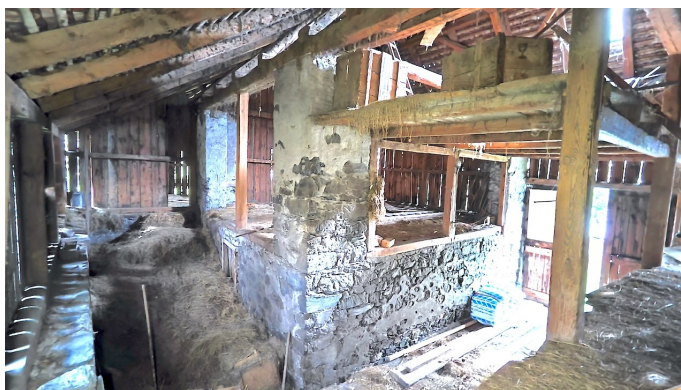
Abb. 3: Balzers, Mälsner Dorf 24. In Ökonomieteil integrierte Eckpfeilerstallscheune.
