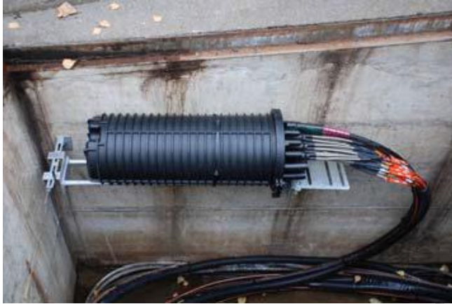
Abbildung 21 Kabelkanalisation: Platzierung Spleissmuffe
