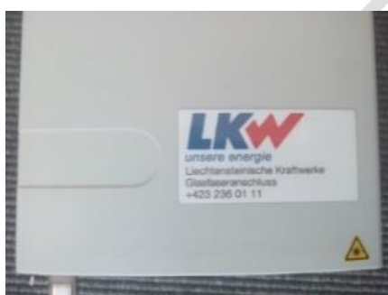
BEP Gehäuseaussenseite
