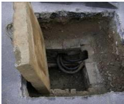
Abbildung 9 Kabelkanalisation: Plattenschacht oben
