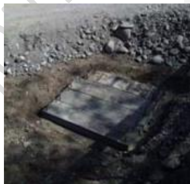
Abbildung 9 Kabelkanalisation: Plattenschacht oben
