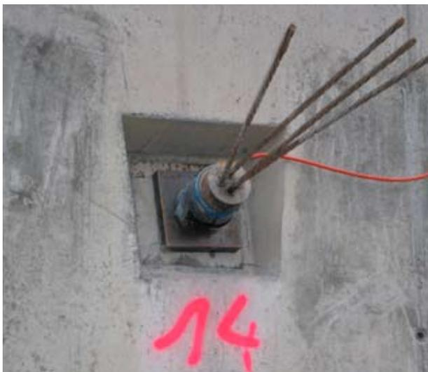
Ankerkopf in Elementwandnische mit Spannlitzen
