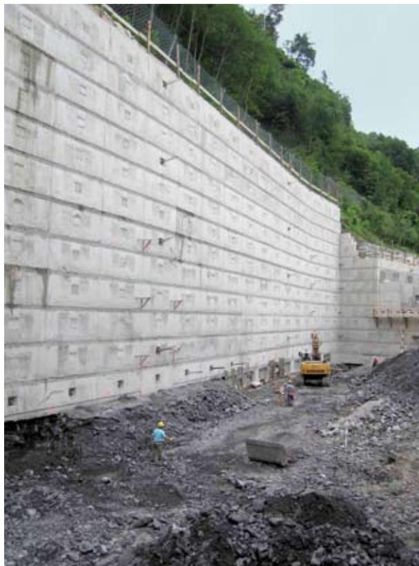
Von oben nach unten errichtete Elementwand mit 23 Meter Höhe
