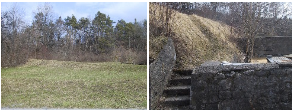
Damm und Weg zur Quaderröfe
