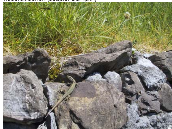
Trockenmauer (Beispiel Triesen)
