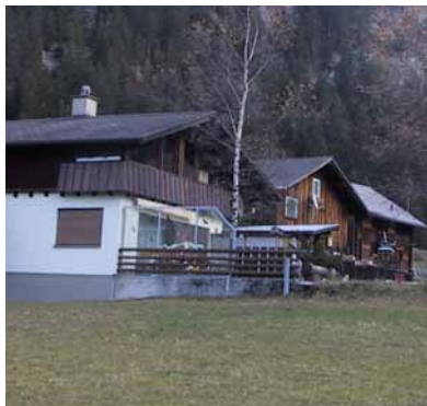
Baulicher Eingriff für Terrasse
