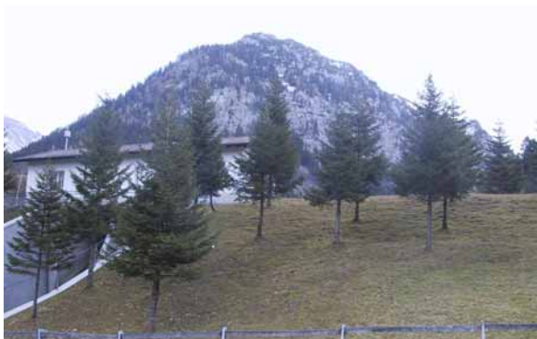
Aufforstung am Staudamm
