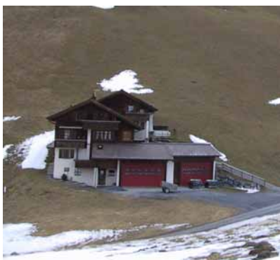
Unsensible Gruppierung von Gebäuden, Störende Garagen
