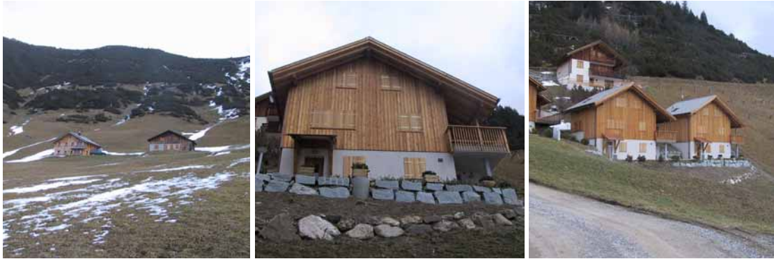
Gebäude stehen direkt auf dem Grund, sind niedrig und passen sich dem Relief an; Neubauten mit überhöhtem Sockel und Verdoppelung des störenden Effektes durch Mauerbau und Aufschüttung.
