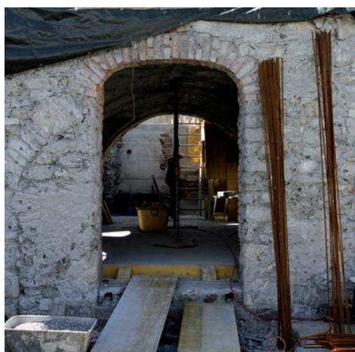
Abb. 5: Nordfassade. Türöffnung von 1925, links davon Rundbogentor der 2. Bauphase.
