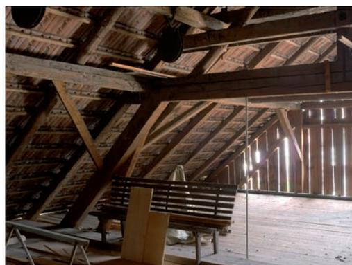
Abb. 6: Am Dachgebälk der Scheune Seilwinde und Seilrollen eines Fuderaufzugs, 2. Viertel 20. Jahrhundert.
