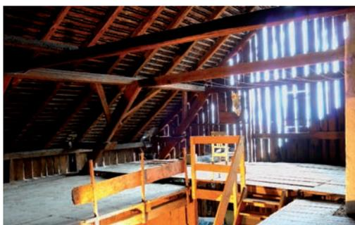
Abb. 4: Dachstuhl von 1872 über der Stall-scheune.
