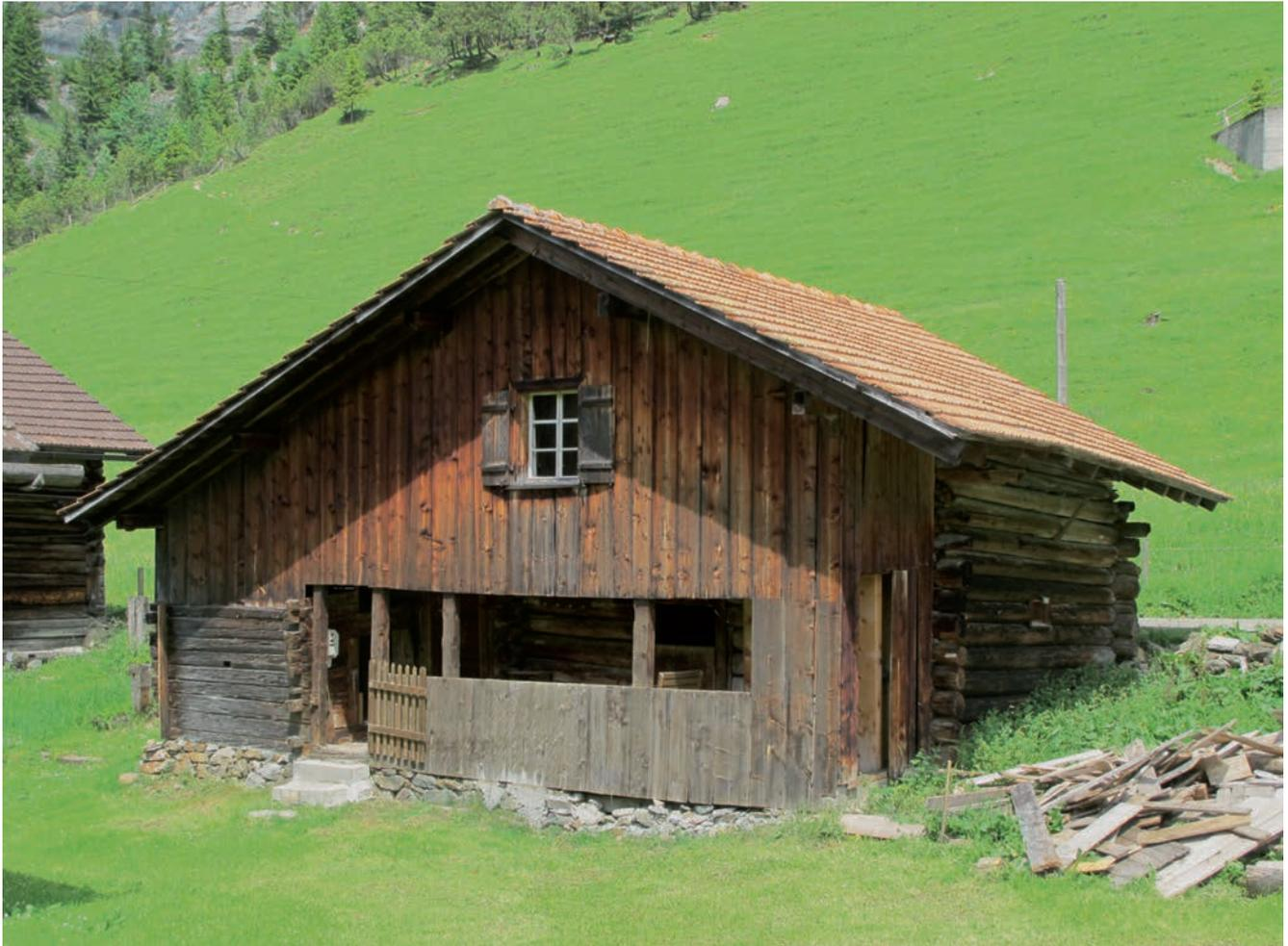
Abb. 3: Südwestansicht mit rückwärtigem Stall in Rundholzbauweise.
