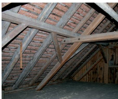
Abb. 5: Schuppenanbau von 1929 mit verschraubtem Dachstuhl aus mechanisch gesägtem Gebälk.
