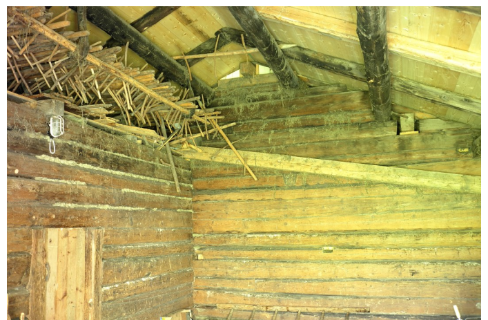
Abb. 4: Heuraum von 1867 mit russgeschwärztem Rafen-Pfetten-Dach.
