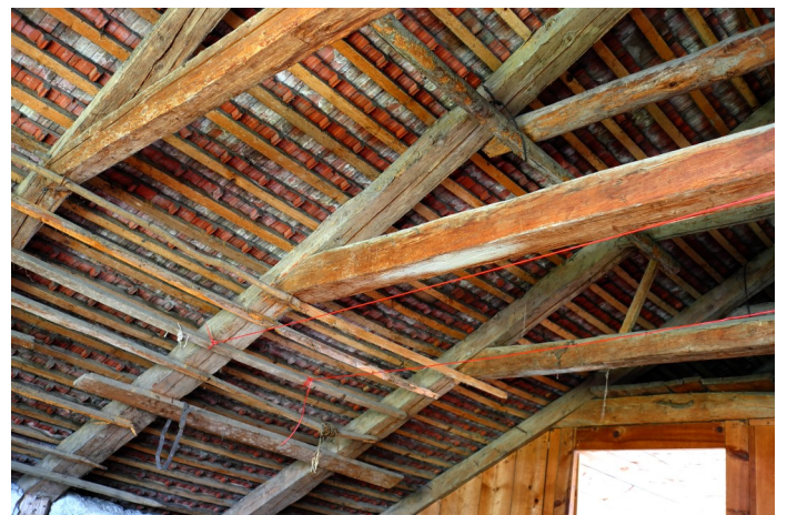
Abb. 5: Dachstuhl von 1875 über dem Wohnhaus, Rafenwerk mit Kehlbalken.
