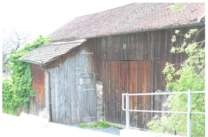
Abb. 8: Stallscheune mit Tenntor, um 1900, links der Streuschuppenanbau von 1915, Ostansicht.
