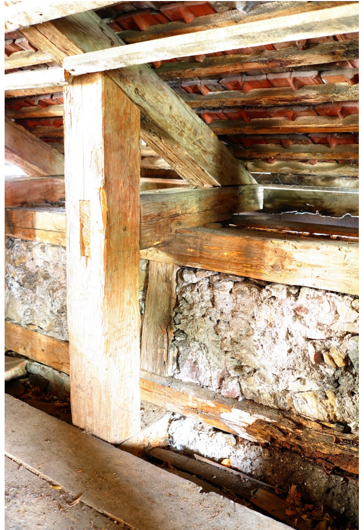
Abb. 4: Dachstuhl von 1875 über dem Wohnhaus, Detail Kniestockkonstruktion.
