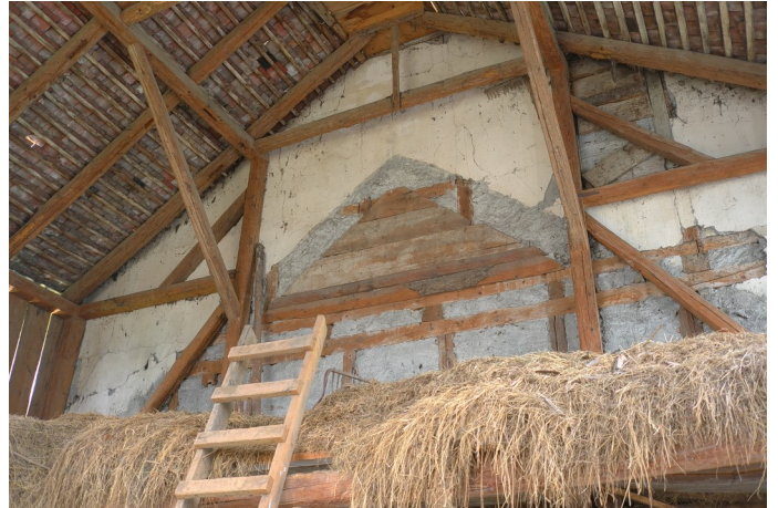
Abb. 6: Südwestliche Aussenwand des Wohnhauses mit Negativ einer älteren Scheune.
