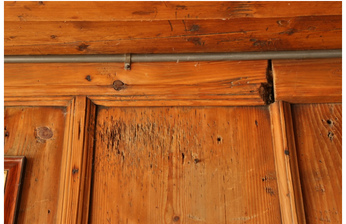
Abb. 9: Wandtäfelung in der Stube mit in barocker Art profilierten Deckleisten.
