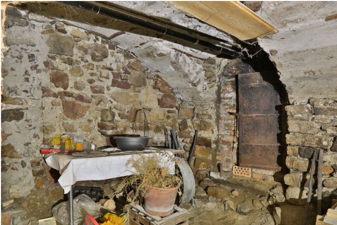
Abb. 5: Gewölbekeller von 1424, im ursprünglichen Innenabgang steht nun ein Räucherofen.
