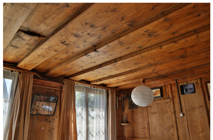
Abb. 8: Die Stube mit der Bohlenbalkendecke von 1525.
