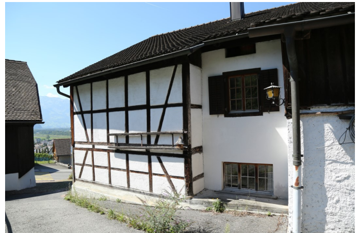
Abb. 7: Ostfassade des Wohnhauses in zweifeldrigem Sichtfachwerk von 1872, fürs 19. Jahrhundert zeittypisch; barockes Fachwerk wurde dreifeldrig abgebunden.
