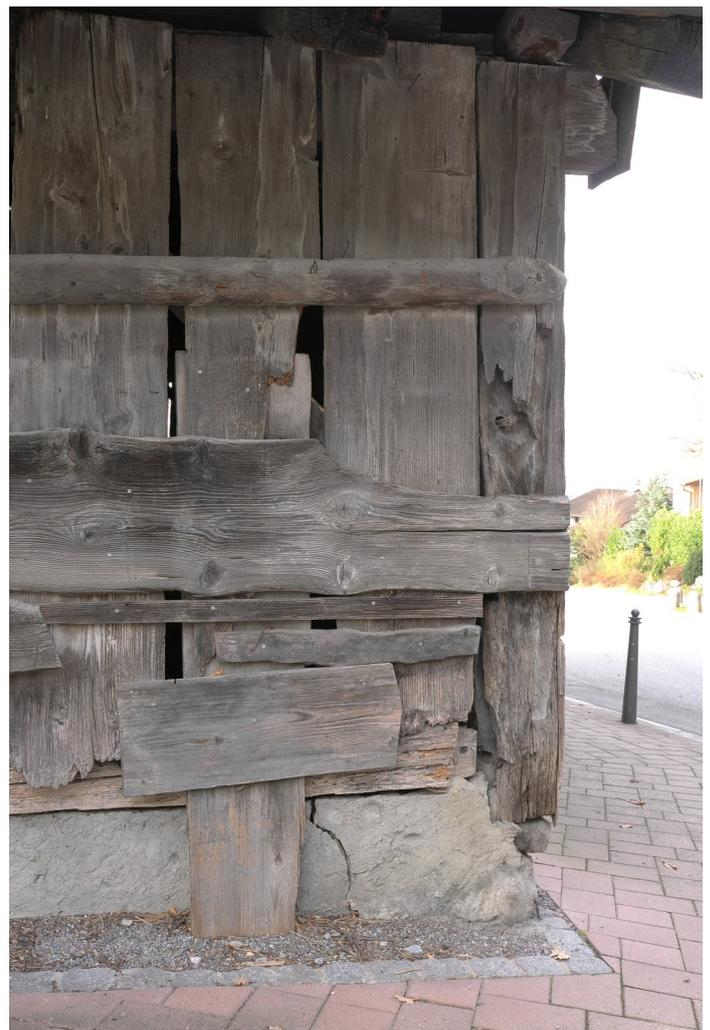
Abb. 3: Nordostecke, Eckständer von 1616 mit eingezäpftem Schwellriegel und Blattsasse zu Kopfbänder.
