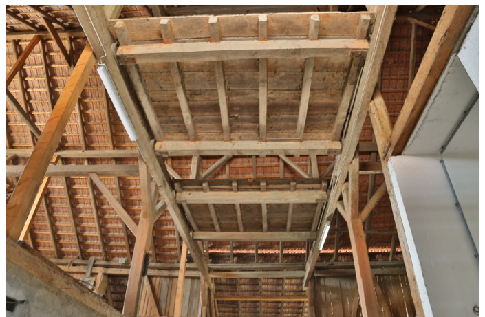
Abb. 7: Mechanisierter Fuderaufzug mit zwei Rollbühnen über der Tenne.
