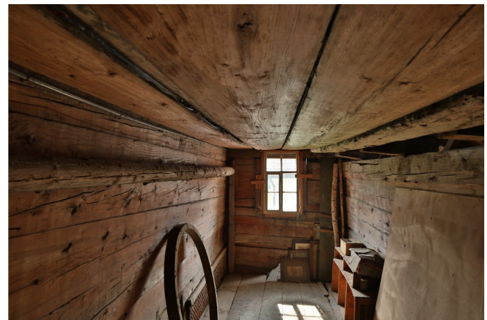
Abb. 3: Laubenkammer von 1701 in Blockbauweise.
