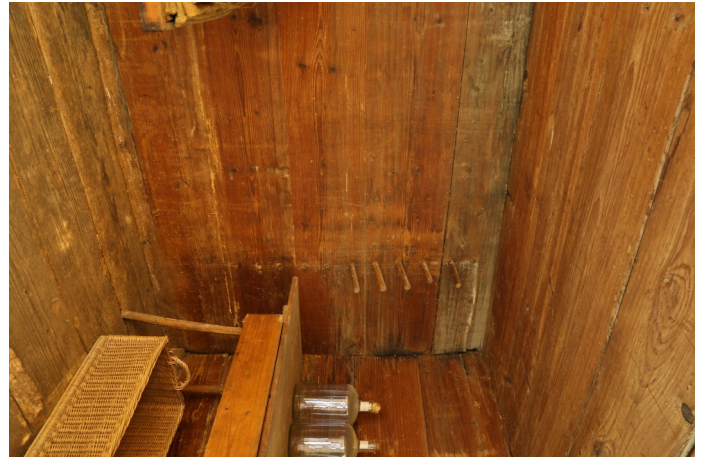
Abb. 5: Firstkammerwand mit Dübelreihe zum Auslegen der Garne eines Heimwebers.
