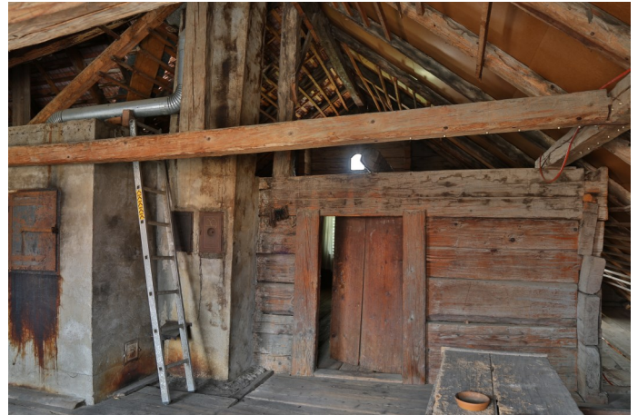
Abb. 2: Firstkammer von 1701 in Blockbauweise.
