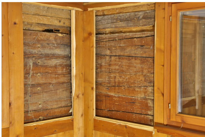
Abb. 2: Kleine Kammer über der Nebenstube, Blockbauwand von 1777 mit einer hausbauzeitlichen Deckennut und einer vertikalen Bohrlochreihe zu einem Zettelbaum eines Heimwebers.
