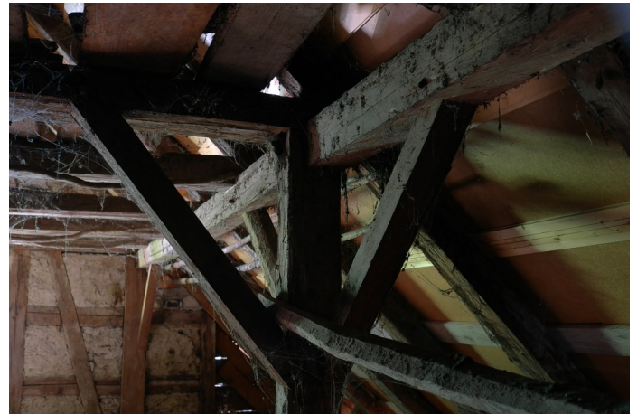
Abb. 6: Der Dachstuhl von 1830 mit Freibinder stehender Art und Versteifung mittels Bügen.
