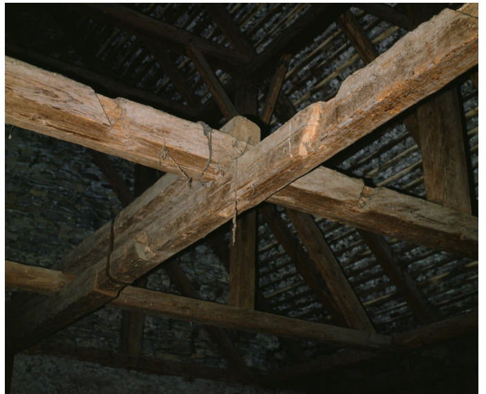
Abb. 6: Ein Längsunterzug trägt die Ankerbalken der Dachstuhlbin- der. Ein Ständer und die angeblatteten Kopfbänder sind später entfernt worden.
