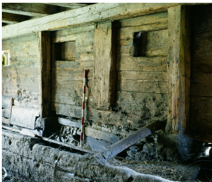
Abb. 4: Die Tenne-Ostwand von 1754 dient als Futterwand.
