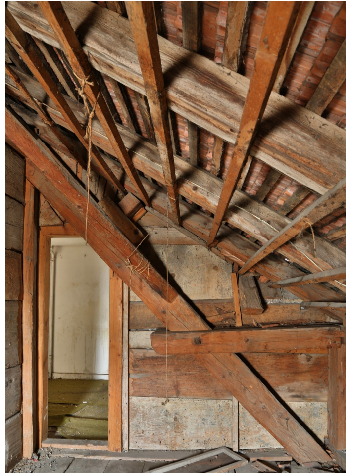
Abb. 5: Dachstuhl von 1878: eisenverschraubter Freibinder.
