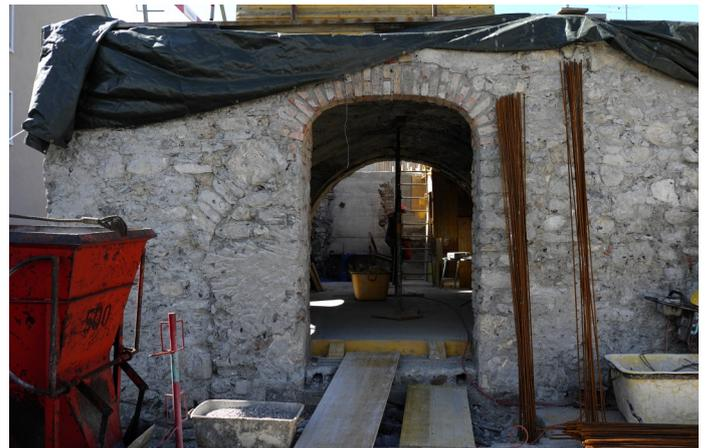
Abb. 5: Nordfassade. Türöffnung von 1925, links davon Rundbogentor der 2. Bauphase.
