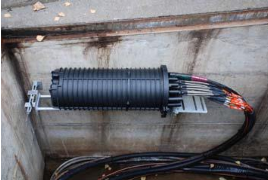
Abbildung 21 Kabelkanalisation: Platzierung Spleissmuffe
