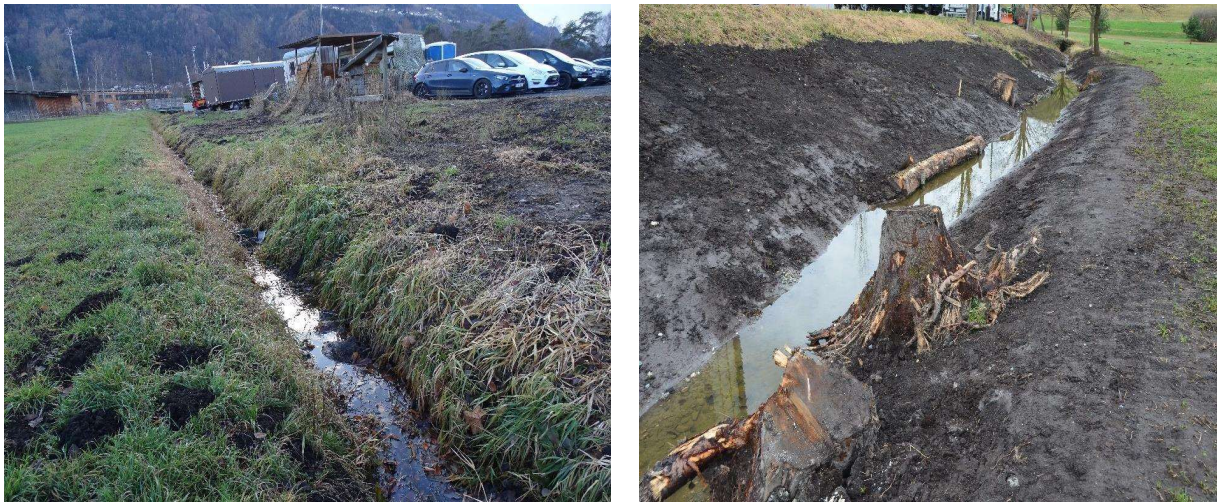
Abbildung 5: Revitalisierung Huebgraben vorher und nachher
