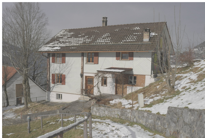
Abb. 1: Südfassade mit Wohnteil von 1845 und dem Schopfanbau von 1900 (rechts), Verkleidung von 1987.
