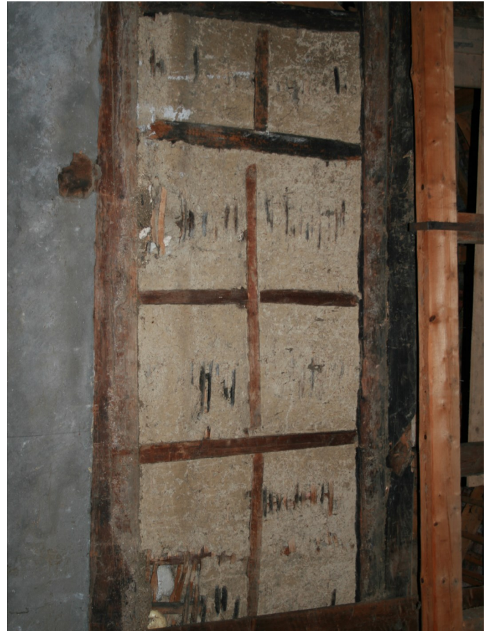
Abb. 6: Vorraum über der Küche, Nordwand von 1607, erst verbrettert, später mit Lehmflechtwerk ausgefacht.
