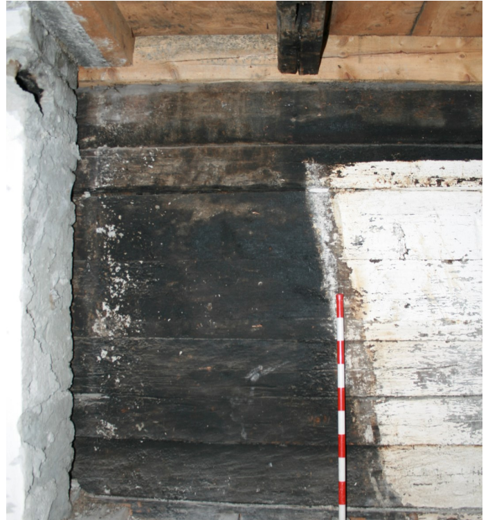
Abb. 5: Vorraum über der Küche, Südwand in Blockbauweise von 1607, vom Küchenrauch stark russgeschwärzt und verpecht, später den Rauch mit Kamin gefasst.
