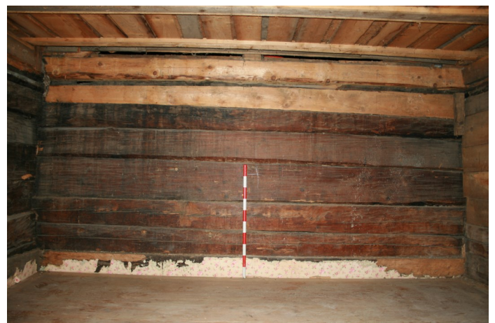
Abb. 4: Kammer über der Nebenstube, Südwand in Blockbauweise von 1607 aus Bauholz zweiter Wahl.
