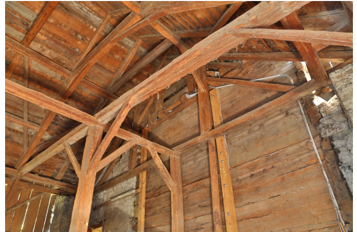
Abb. 2: Scheunenannbau der 1860er-Jahre, Wände kürzlich teilweise erneuert.
