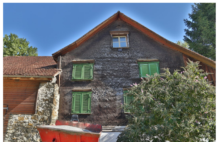
Abb. 4: Hauptfassade in der Gestaltung von 1857 – A.20. Jahrhundert.
