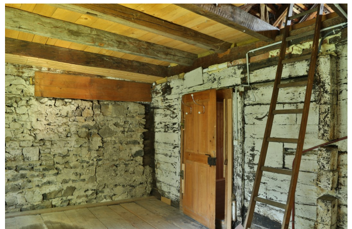
Abb. 6: Vorraum im Obergeschoss, Blockbauwand von 1642 mit Türgericht gotischer Art.
