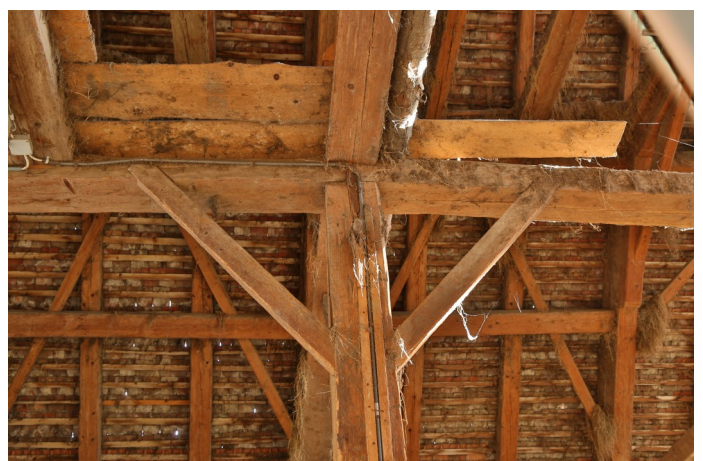
Abb. 4: Gesägte Kopfbänder sichern vor Längsneigung, sie sind unten eingezäpf, oben angeblattet.
