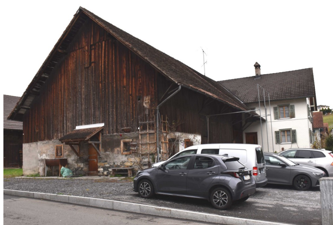
Abb. 4: Eschen, Hinterdorf 7, Südwestansicht Ökonomieteil.
