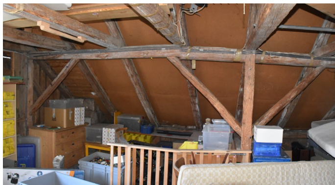
Abb. 3: Eschen, Hinterdorf 7, Dachstuhl.
