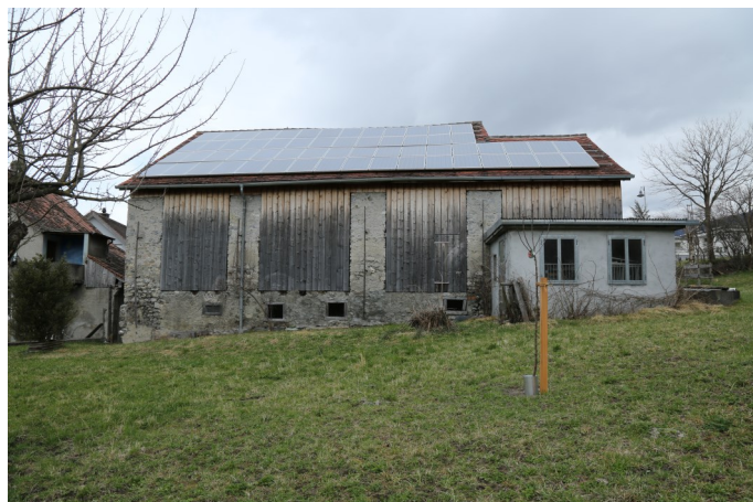
Abb. 2: Südfassade der Stallscheune von 1905, mit dem Schuppenanbau von 1929 und dem Hühnerstallanbau von 1932.
