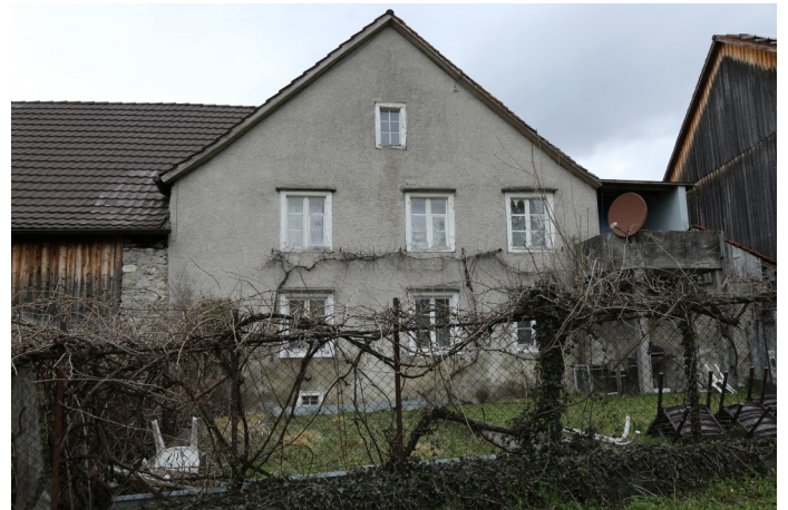
Abb. 3: Südfassade des Wohnhauses in der Gestaltung des 19. Jahrhunderts.
