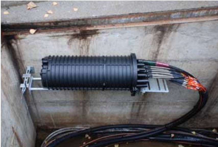
Abbildung 21 Kabelkanalisation: Platzierung Spleissmuffe
