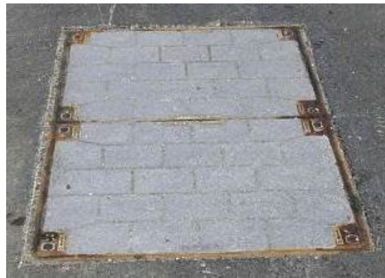
Abbildung 6 Kabelkanalisation: Einstiegschacht Ansicht oben
