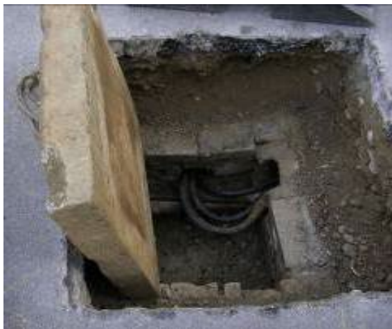
Abbildung 9 Kabelkanalisation: Plattenschacht oben
