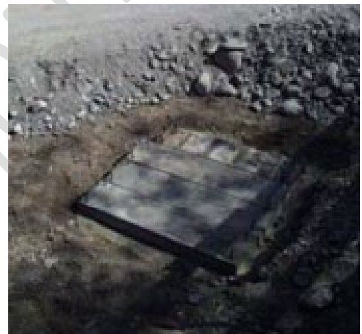
Abbildung 9 Kabelkanalisation: Plattenschacht oben
