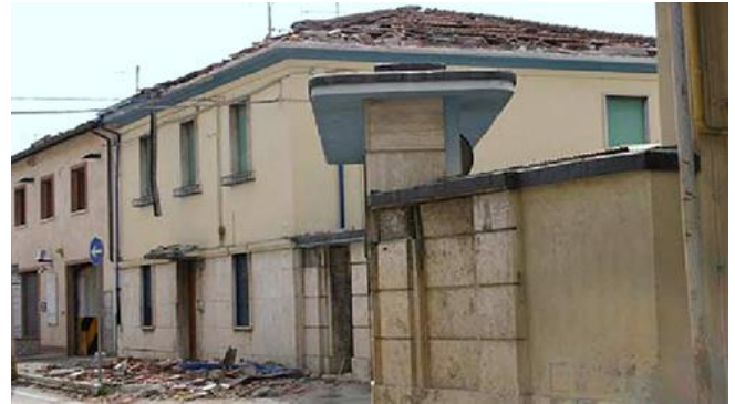
Abb. 2.10.2 > Heruntergefallene Dachziegel
