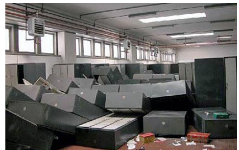
Abb. 2.22.5 und 2.22.6 > Kippen mehrerer Regalreihen infolge des Domino-Effekts
