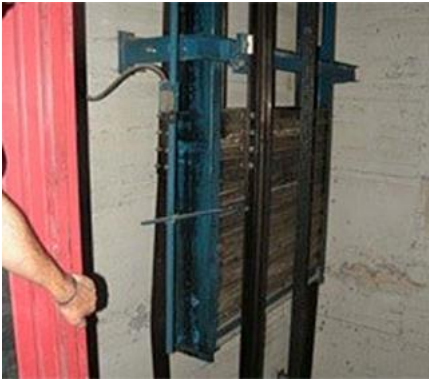
Abb. 2.19.1 > Führungsschiene durch Gegengewichte verbogen
