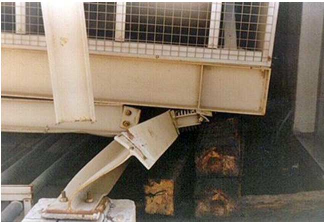
Abb. 2.16.3 und 2.16.4 > Gleitverschiebungen/Instabilitäten
