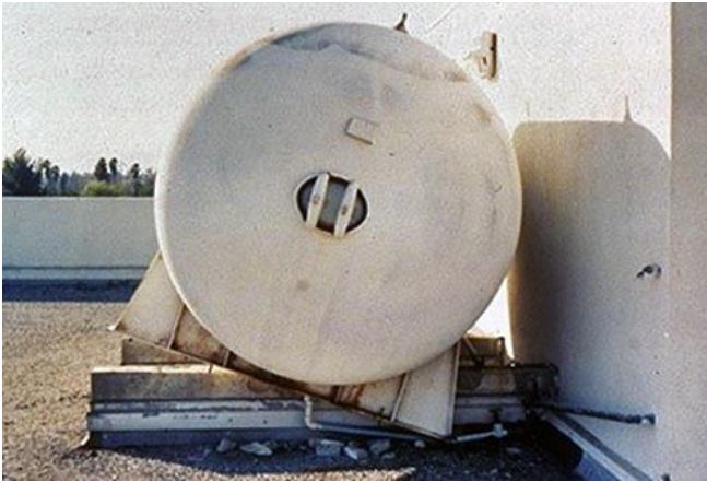
Abb. 2.17.1 und 2.17.2 > Trägheitsversagen bei Tankwänden
