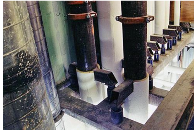
Abb. 2.18.11 > Lagerung von Steigleitungen bei Deckendurchbrüchen
