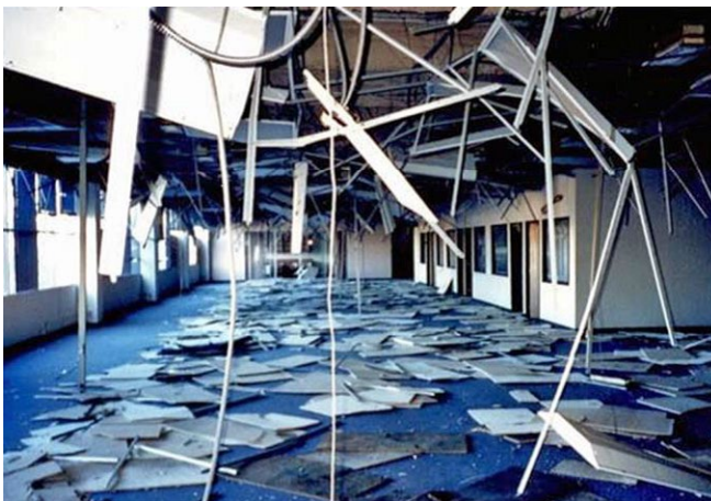
Abb. 2.2.1 bis 2.2.4 > Schäden an Deckenbekleidungen
