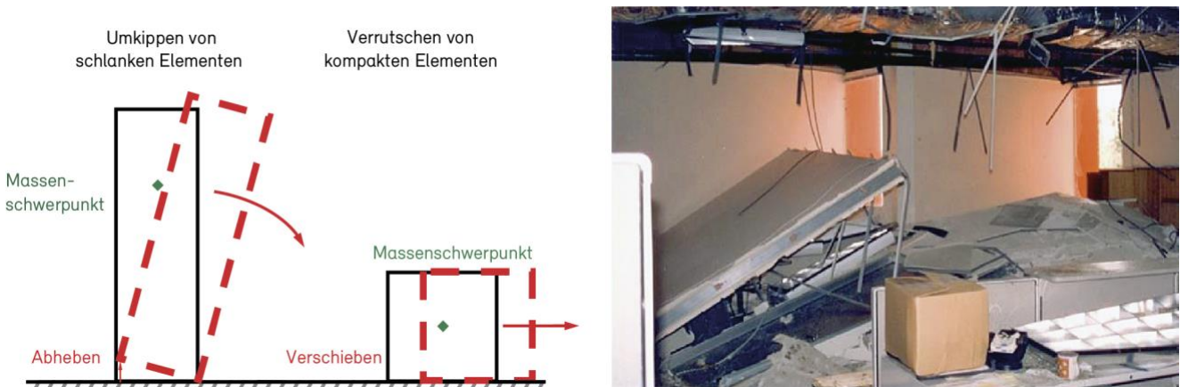
Abb. 1.2 Umgekippte Trennwände, herabgefallene Unterdeckenelemente und Beleuchtungskörper, Northridge Erdbeben 1994
