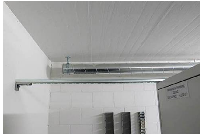
Abb. 2.13.5 > Verankerung von freistehenden Schrankeinheiten
