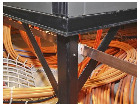
Abb. 2.3.8 > Horizontale Stabilisierung durch Diagonalstreben
