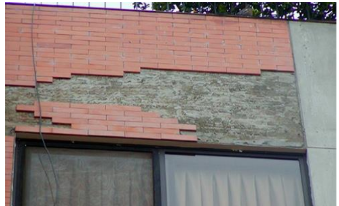
Abb. 2.5.2 > Ablösung von geklebten Elementen
