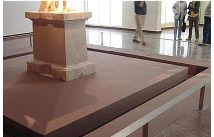
Abb. 2.25.5 > Schwingbereich eines abgehängten Ausstellungsobjekts
