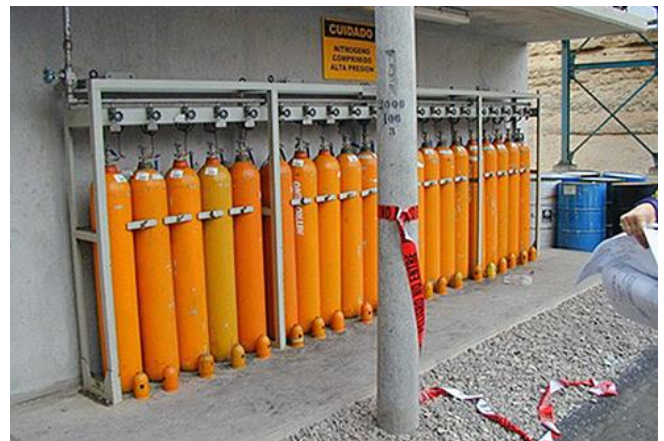
Abb. 2.17.8 > Befestigung von Zylinderflaschen
