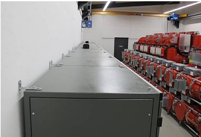
Abb. 2.13.6 und 2.13.7 > Sicherung von Schränken an der Wand
