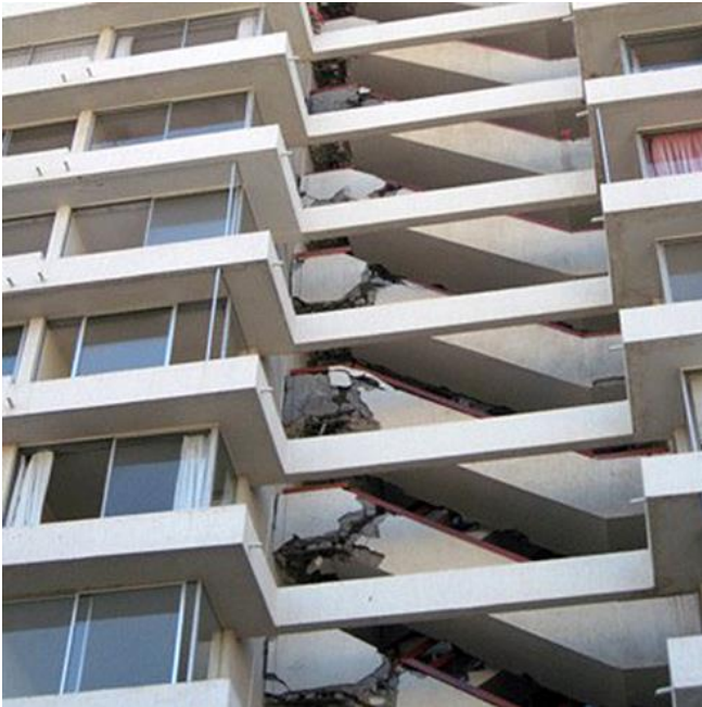
Abb. 2.7.1 und 2.7.2 > Druckdiagonalen im Treppenlauf
