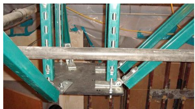
Abb. 2.15.4 > Aussteifung schwerer Leuchtkörper
