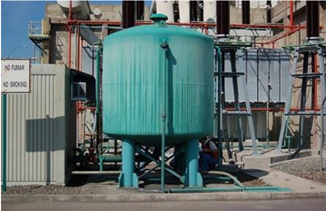
Abb. 2.17.5 > Aussteifung von aufgeständerten Tanks
