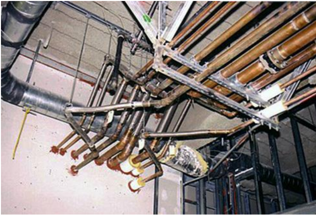
Abb. 2.18.10 > Flexible Verbindungen bei Wanddurchbrüchen, Aussteifung von Leitungstrasse
