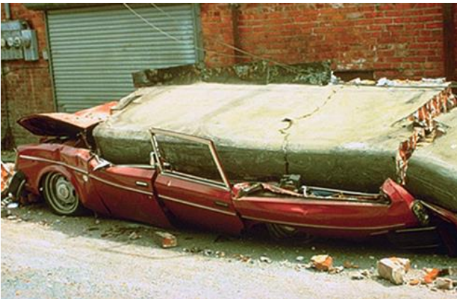
Abb. 2.6.1 und 2.6.2 > Versagen infolge Trägheitskräften quer zur Brüstungsebene
