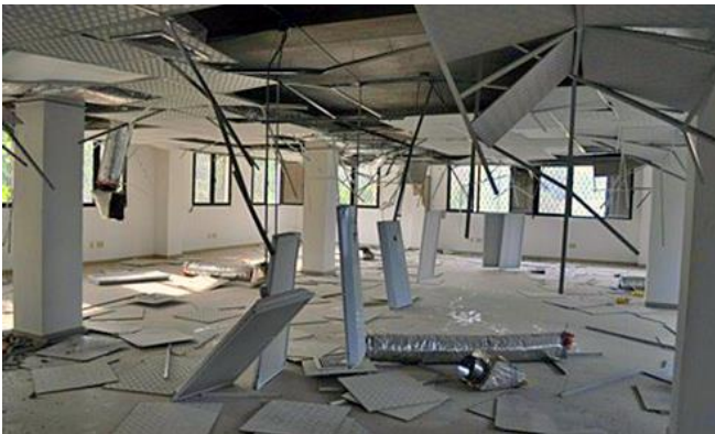
Abb. 2.15.1 und 2.15.2 > Absturz von Beleuchtungselementen
