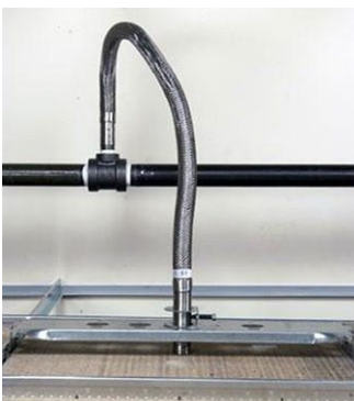
Abb. 2.12.3 > Flexible Abzweigung von Hauptleitung
