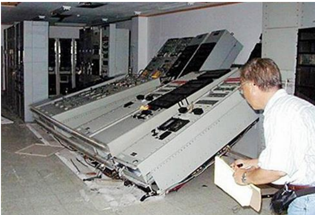
Abb. 2.13.1 und 2.13.2 > Umgekippte Steuerschränke
