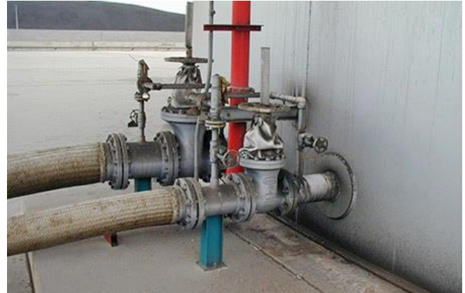
Abb. 2.17.6 > Flexibler Leitungsanschluss
