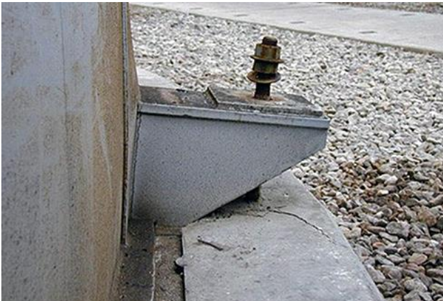
Abb. 2.17.3 > Beschädigte Verankerung
