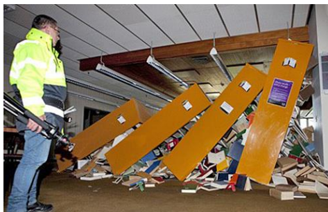
Abb. 2.22.5 und 2.22.6 > Kippen mehrerer Regalreihen infolge des Domino-Effekts
