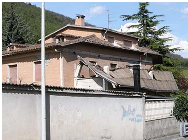
Abb. 2.9.2 > Eingestürztes Vordach
