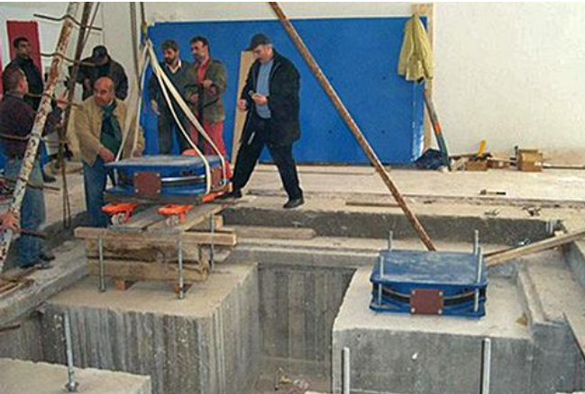
Abb. 2.25.6 und 2.25.7 > Schwingungs isoliertes Fundament für eine Skulptur
