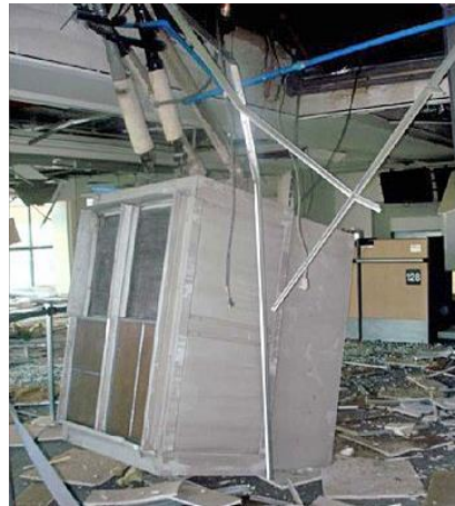
Abb. 2.16.2 > Ungenügend ausgesteiftes Element
