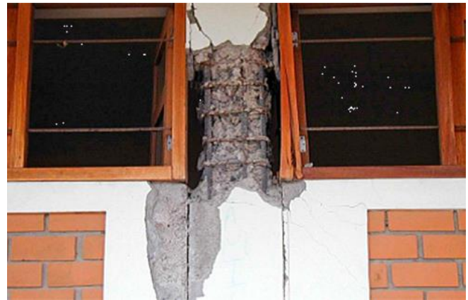
Abb. 2.4.2 > Schubbruch in kurzer Stütze bei Mauerwerksausfachung
