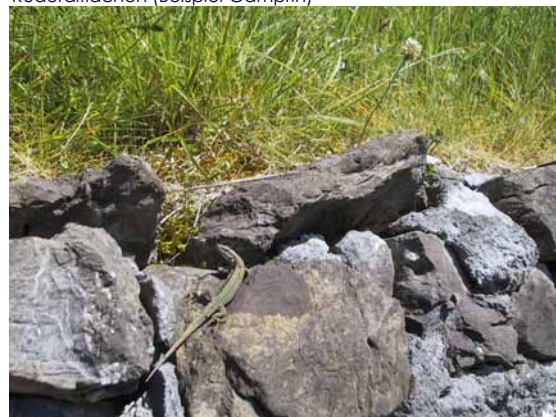
Trockenmauer (Beispiel Triesen)
