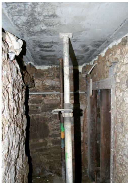
Abb. 3: Die Ostecke der Nebenstube in Mauerwerk von 1870. Die Sturzhölzer der Fenster sind angekohlt. Sie wurden nach dem Brand wieder verwendet.
