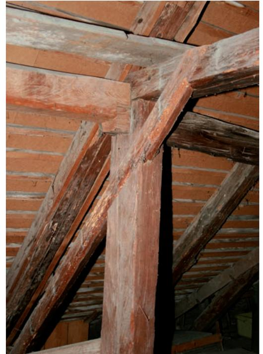
Abb. 3: Dachstuhl von 1837 mit überblatteter, quer versteifter Strebe.
