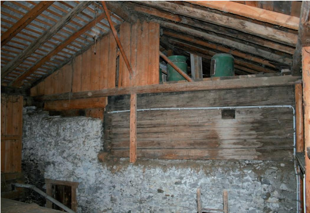
Abb. 5: Nordwand des Wohnhauses von 1558 in Mauerwerk und Blockbauweise, mit Kammerfensterchen aus der Erbauungszeit.
