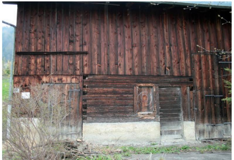
Abb. 7: Westfassade der Stallscheune von 1922 mit Stallwand in schwalbenschwanzverzinkter Blockbauweise.
