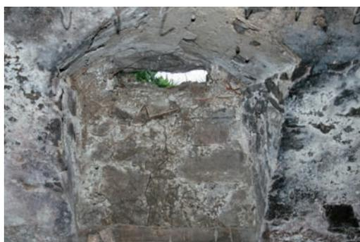
Abb. 4: Kellerzugang mit dem Ansatz eines entfernten Tonnengewölbes. Ansicht von Westen.
