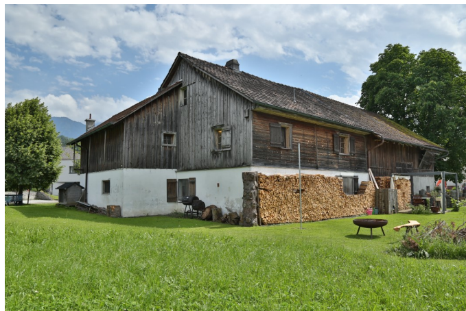
Abb. 1: Ruggell, Spidach 7. Nordwestansicht: gegen diese beiden Fassaden stiess bis 1865 das Nachbarhaus Nr. 28.
