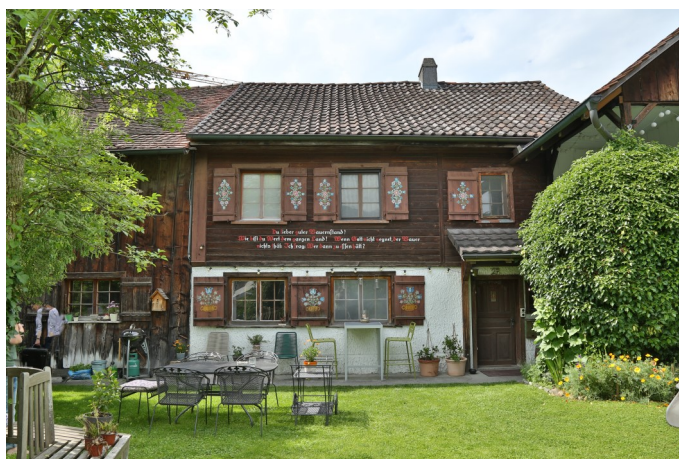
Abb. 2: Dekorativ bemalte Südostfassade des Wohnhauses.
