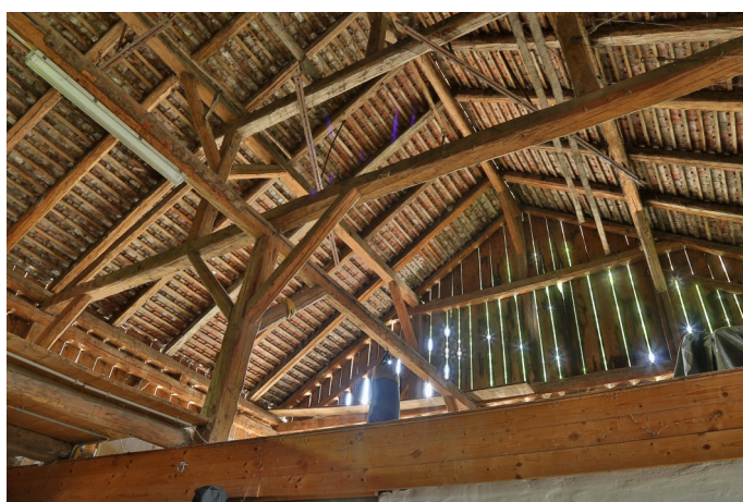
Abb. 3: Scheunenkonstruktion von 1922 mit Schienen der Laufkatze des Zangenaufzugs.
