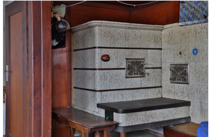
Abb. 4: Ofenanlage von 1916 Typ „Schädler Nendeln“ mit Jugendstilzier.
