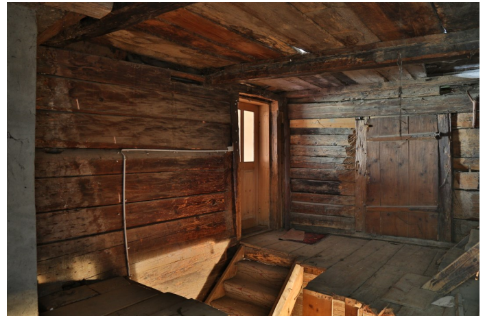
Abb. 2: Wohnhaus-Obergeschoss: die Wände sind 1800 aus Bauholz von 1739 in verblockter Ständerbauweise wieder aufgerichtet worden.
