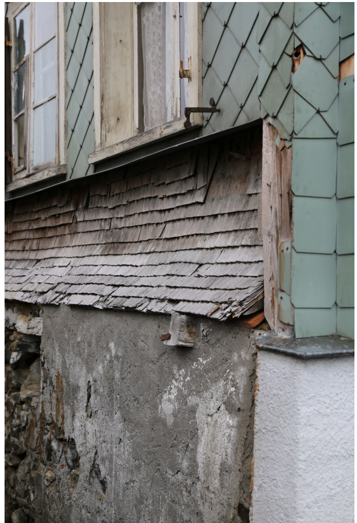
Abb. 5: Die Nordwestfassade des Wohnhauses trägt unter der Verkleidung aus Faserzementschiefer einen Schlaufschirm des 19. Jahrhunderts.
