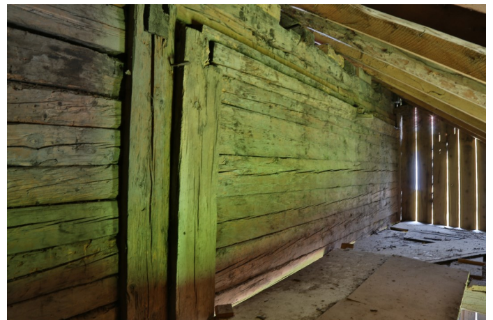
Abb. 3: Nordostfassade des Wohnhauses: die Wände sind 1800 aus Bauholz von 1739 in verblockter Ständerbauweise wieder aufgerichtet worden.
