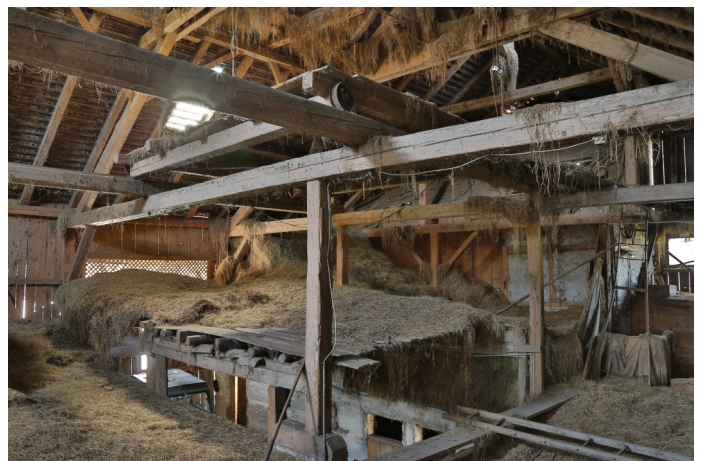
Abb. 6: Rollbühne über der Tenne zum Ablad von Getreide- und Heufuhren mittels Fuderaufzug.
