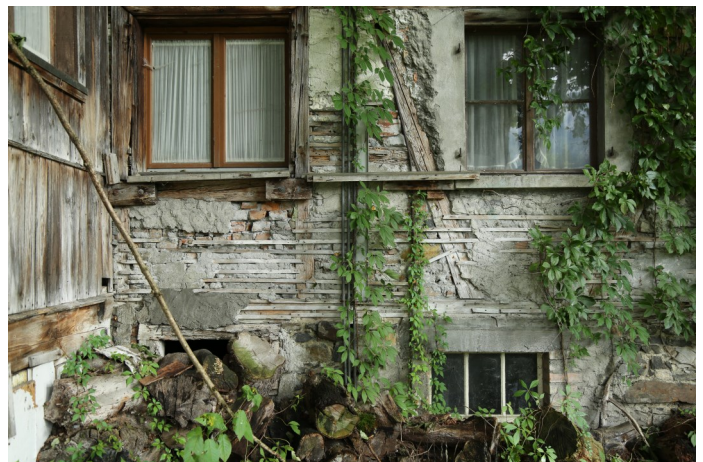
Abb. 3: Der Küchenbereich in überputztem Fachwerk.
