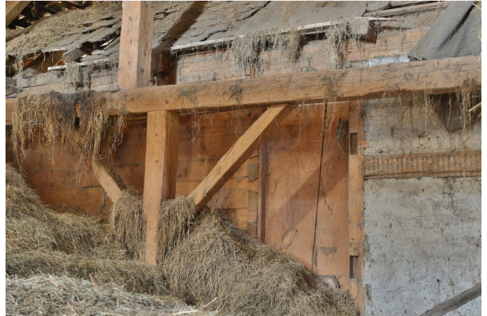
Abb. 2: Der Blockbaubereich ist mit Schwalbenschwänzen verzinkt, dem sogenannten Montafoner- oder auch Tirolerstrick.
