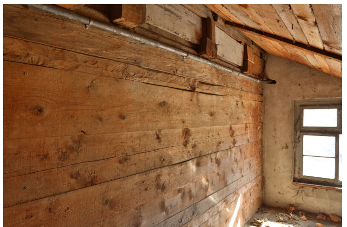
Abb. 4: Blockbauwand von 1882 aus mechanisch gesägten bohlenartigen Wandbalken.
