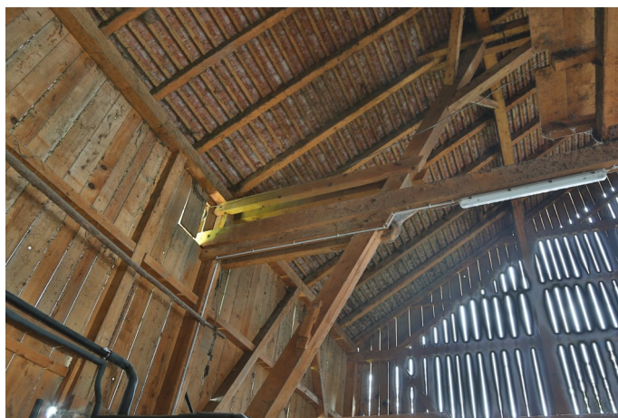
Abb. 7: Die Scheune von 1938 in eindrücklicher Zimmererarbeit, zeittypisch mit eisenverschraubten Bindern und Zangen.
