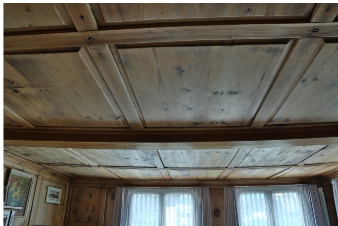
Abb. 5: Stube mit dekorativer Wand- und Deckentäfelung der Hausbauzeit 1806.
