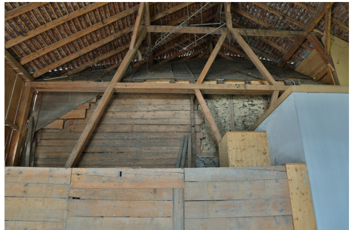
Abb. 2: Wohnhaus-Nordostwand von 1806 in der Scheune von 1938: Gwettkopf-Blockbauweise für Stuben und Kammern (links); Lehmflechtwerk für den Vorraum über der Küche (rechts); links oben Rundschindelschirm mit der Dachschräge der 1938 abgetragenen Scheune.
