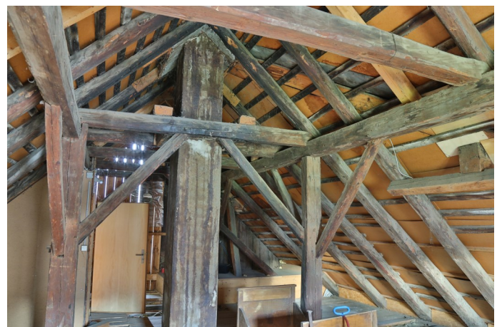
Abb. 3: Dachstuhl von 1806, in stehender Art abgebunden und mit weit gespannten Fuss- und Kopfbügel längs- und querversteift.
