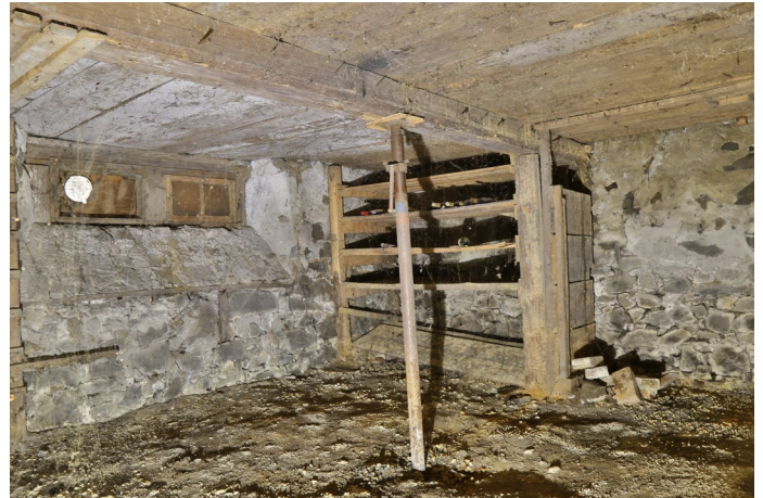
Abb. 2: Kellergeschoss, in der Südwand Bandfenster mit innenseits stark abfallender Sohlbank, was an die Einrichtung eines Webkellers erinnert.
