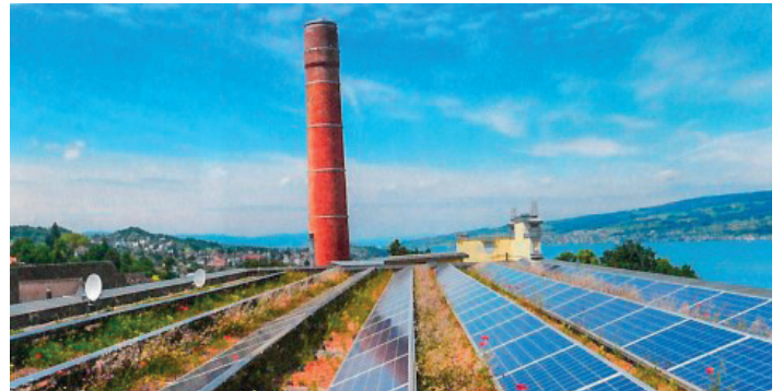
Abbildung 9: Links: Begrüntes Dach zur Förderung der Biodiversität Rechts: Kombination einer Blumenwiese mit einer Photovoltaik-Anlage auf einem Flachdach. Die Dachretention bietet multifunktionale Lösungen. Das Niederschlagswasser wird im Boden des begrünten Daches zwischengespeichert und zum Teil gedrosselt abgeleitet. Der Grossteil wird durch die Pflanzen aufgenommen bzw. verdunstet.
