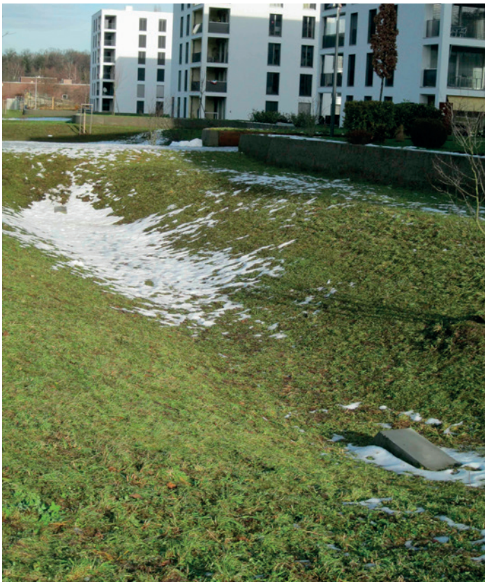
Abbildung 12: Retentions- und Versickerungsbecken ohne und mit ständiger Wasseroberfläche.
