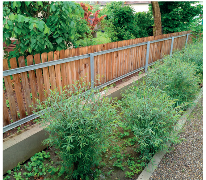
Abbildung 10: Die Fotos zeigen Gräben, in denen das anfallende Niederschlagswasser zurückgehalten und versickert wird. Links: Graben entlang einer Quartierstrasse, rechts: kleiner Graben zur Versickerung des Dachwassers auf einer Liegenschaft.
