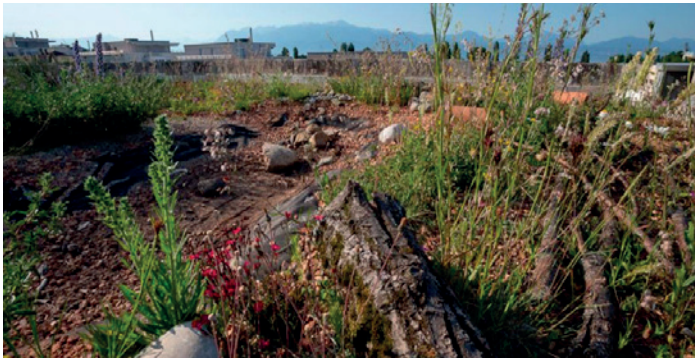
Abbildung 9: Links: Begrüntes Dach zur Förderung der Biodiversität Rechts: Kombination einer Blumenwiese mit einer Photovoltaik-Anlage auf einem Flachdach. Die Dachretention bietet multifunktionale Lösungen. Das Niederschlagswasser wird im Boden des begrünten Daches zwischengespeichert und zum Teil gedrosselt abgeleitet. Der Grossteil wird durch die Pflanzen aufgenommen bzw. verdunstet.
