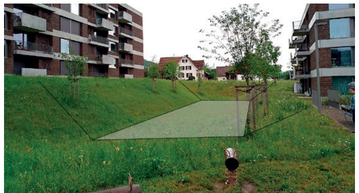
Abbildung 7: Skizze der Funktionsweise einer Versickerungsmulde (links) und Beispiele aus dem Siedlungsgebiet (rechts). Eine Detailskizze eines Versickerungsbeckens ist im Modul DA (Abb. 9) der VSA-Richtlinie zu finden.
