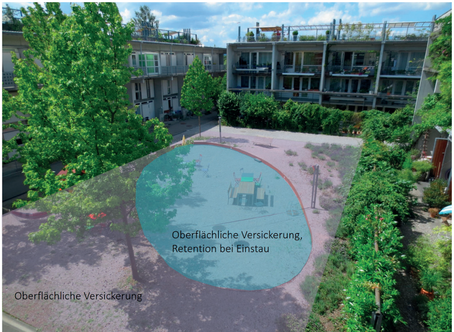
Abbildung 3: Beispiel einer gut in die Quartiergestaltung integrierten Siedlungsentwässerung: Im äusseren Bereich des Platzes wurde Schotterrasen (violett) und im Inneren eine Kiesfläche (blau) ausgebildet, die bei Starkregen als Retentionsvolumen dient und kurzfristig eingestaut werden kann.
