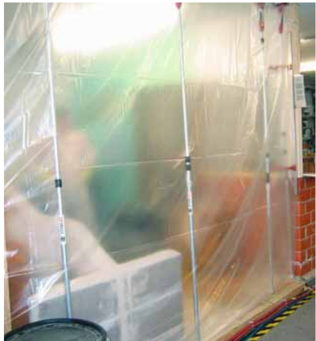
Bild 4: Schwarz-Weiss-Trennung durch Abgrenzung mit Plastikfolie.
