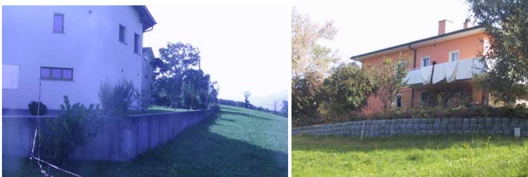
Unnötige und störende Aufschüttungen in das sonst sanft abfallende Gelände
