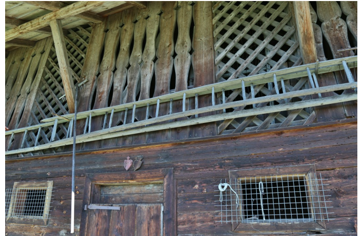
Abb. 5: Ziervoll gesägte Lüftungswand zum Heuraum von 1915.
