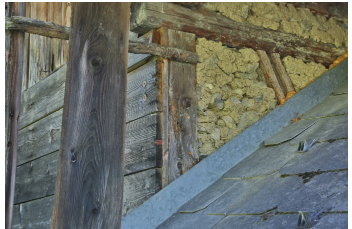
Abb. 3: Die Wände des Obergeschosses bestehen in Fachwerk, ausgemauert mit gebrochenem Rüfegestein und Lehm.
