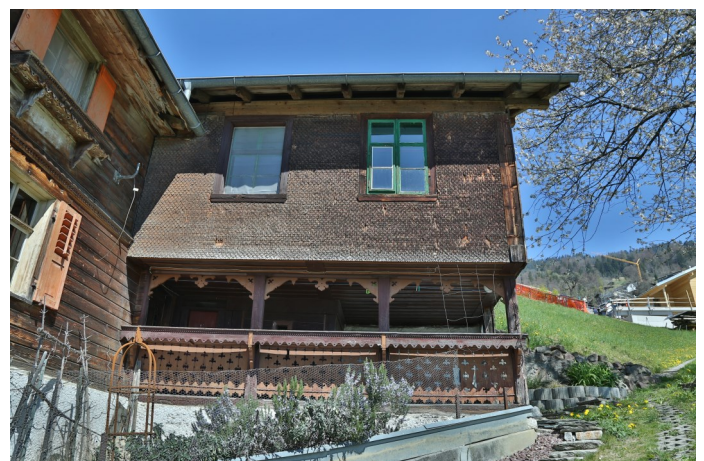
Abb. 4: Schreinerwerkstatt von 1899 und verandaartiger Zugang zum Wohnhaus, talseitige Ansicht.
