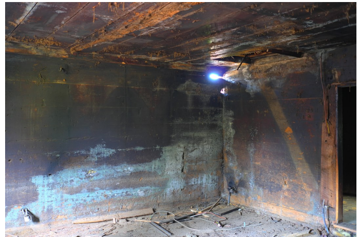
Abb. 5: Die Stube von 1534 mit der Spur einer Treppe ins Obergeschoss.
